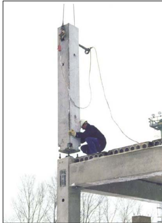
Abb. 14: Verbindung Stütze-Stütze [I 1]
