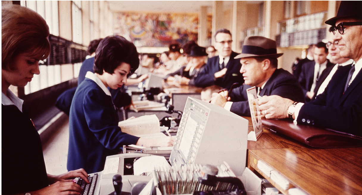
Abb. 41: SABRE Buchung. Das spezielle Interface erlaubt über codierte Papierkarten die Auswahl aus einer Liste zur Verfügung stehender Flüge. Über einen Button konnte ein spezifischer Flug im Hauptrechenzentrum per Telefonleitung angefragt werden und stand dieser zur Verfügung, leuchtete eine entsprechende Lampe auf. Die Buchung konnte durch die Mitarbeiterin bestätigt werden und die Passagierdaten anschließend per Tastatur eingegeben werden. Ein Set kostete 16.000 US Dollar (entspricht derzeit ca. 137.000 US Dollar). Ab 1976 wurde dieses opto-elektrische Interface durch Bildschirmterminals ersetzt (IBM Archive, 1962).
