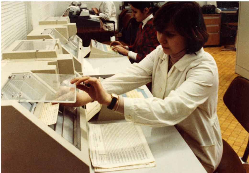
Abb. 77: Dateneingabe am ESER EC-1022 Großcomputer, 1982. Die auf den tabellarisch angelegten Vordrucken per Hand geschriebenen Programmieranweisungen werden von den Operatorinnen mithilfe einer spezifischen Tastatur auf Lochkarten übertragen, welche in der Folge am Großrechner als Programm eingelesen werden können (Центр государственного хранения космической документации 1982).
