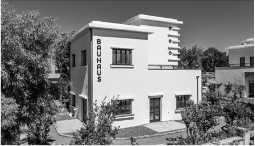
Abb. 3: Ehemaliger französischer Zollposten nach den Renovierungsarbeiten. Foto: Barak Brinker (CDA), 2019
