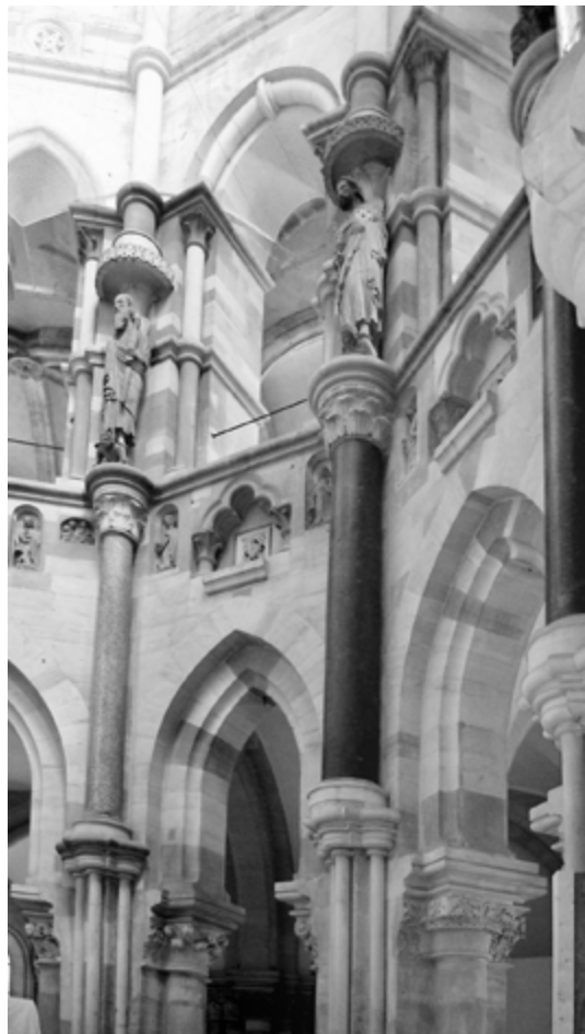
Abb. 3: Magdeburg, Domchor (nach 1209), aus dem ottonischen Vorgängerbau übernommene und im modernen Wandsystem ausgestellte antike Spoliensäulen
