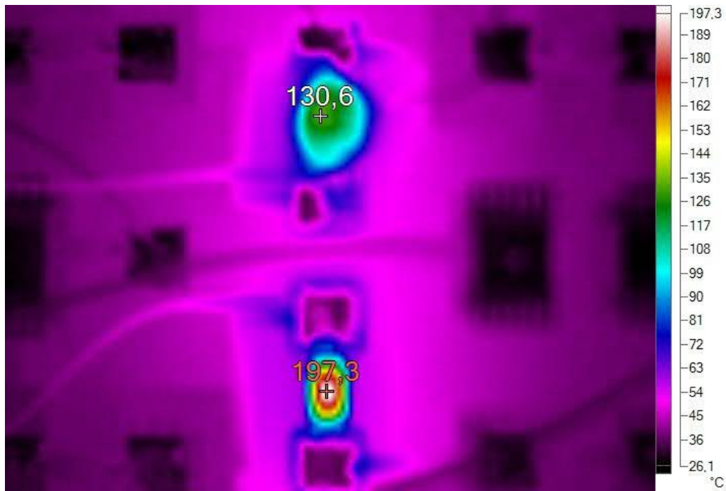
Abb. 5.4: Temperaturvergleich RZI2 mit Vergussmasse (oben) und RZI7 (unten)
