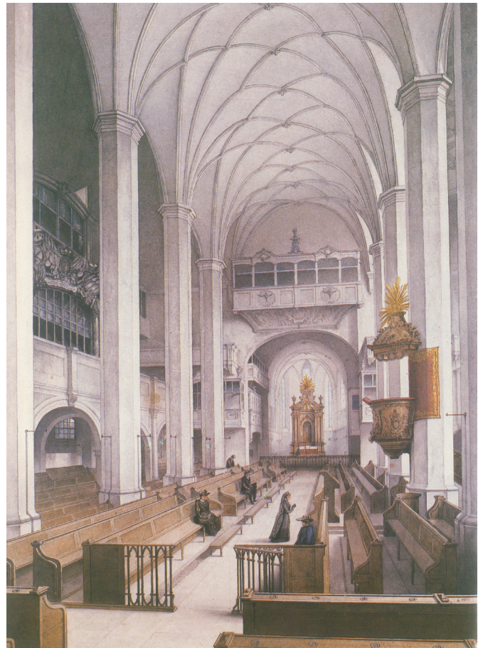
Abb. 31: Innenansicht der Thomaskirche vor den Umbauten des 19. Jahrhunderts (Thomaskirchgemeinde Leipzig)
