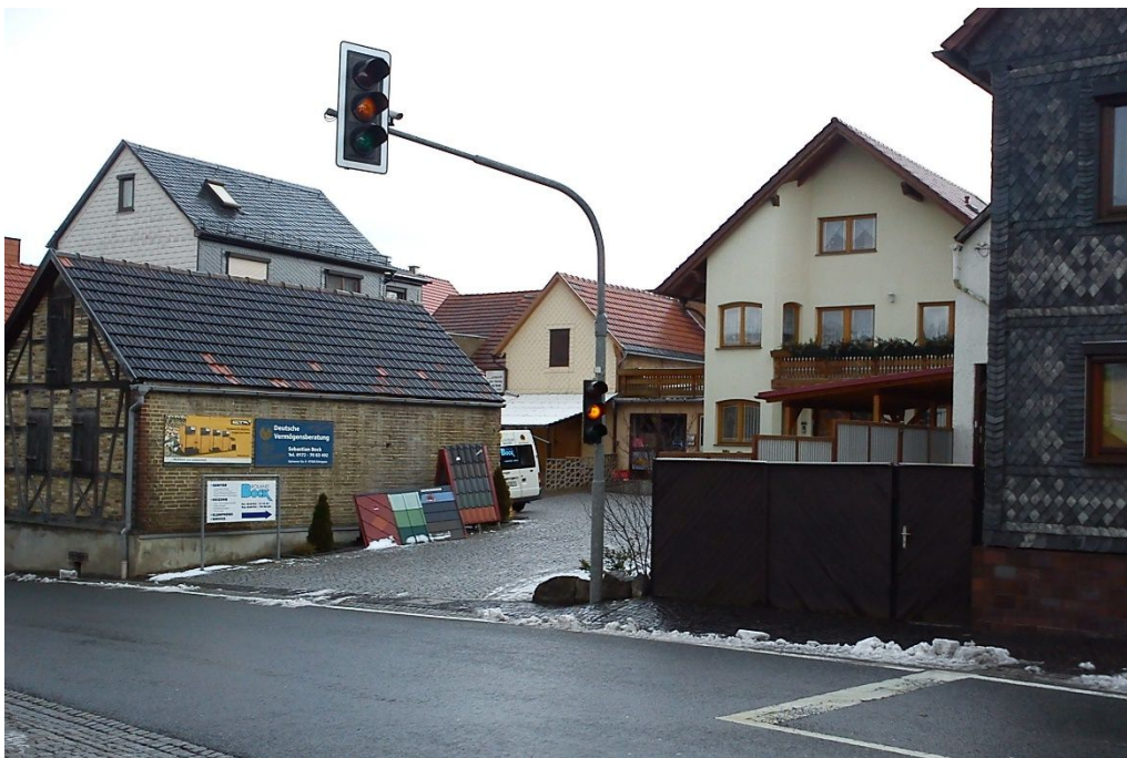
Hausneubau Bock hinter dem ehemaligen Gasthaus Tischer
