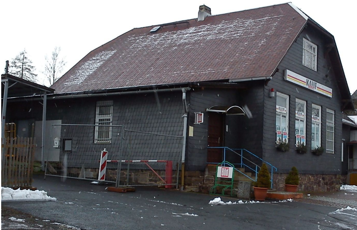
Ehemaliges Schulgebäude, zuletzt Nahkauf Nordhaus Anfang 2012
