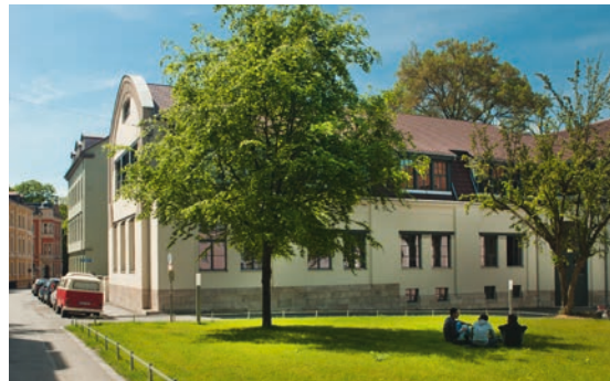
Bauhaus-Universität Weimar, Werkstattgebäude, einstige Großherzogliche Kunstgewerbeschule, 1905/06
