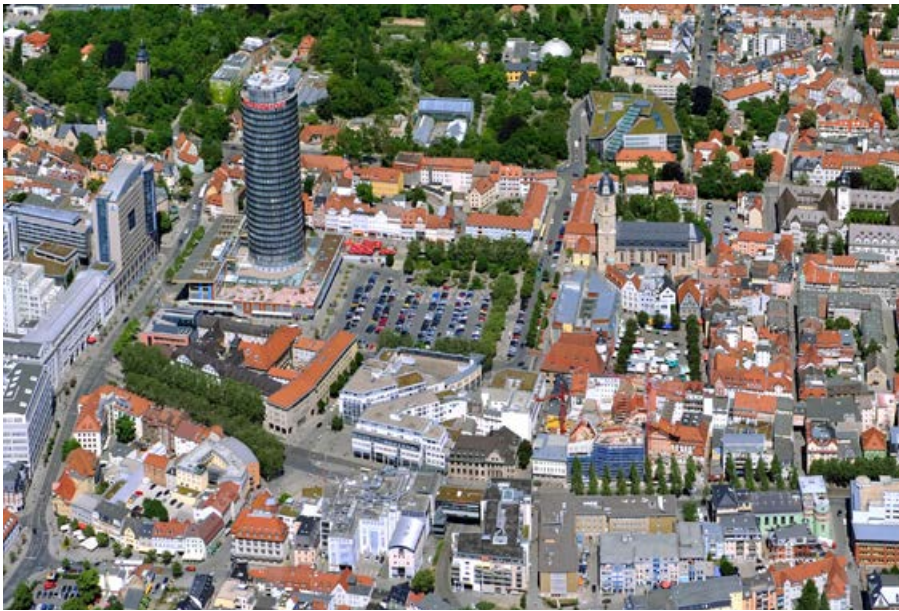
Stadtzentrum Jena von Süden
