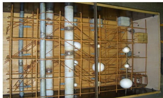
Abb. 14: Betonkörper vor dem Betonieren
