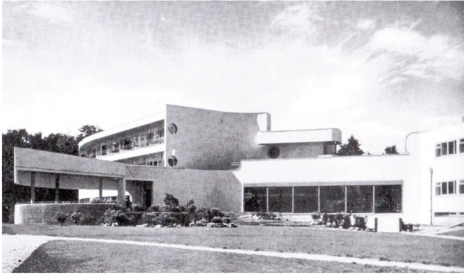
Abb. 5.4.6: Wohnheim, aufgenommen von der Südseite.
