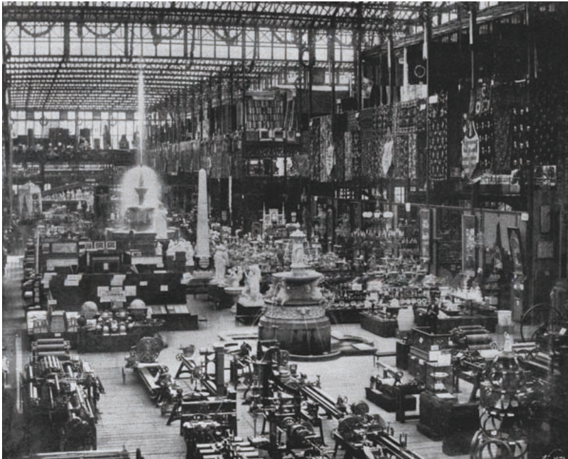
Abb. 2.2.4: Industrie-Ausstellungsgebäude in München, Innenansicht 1845.
