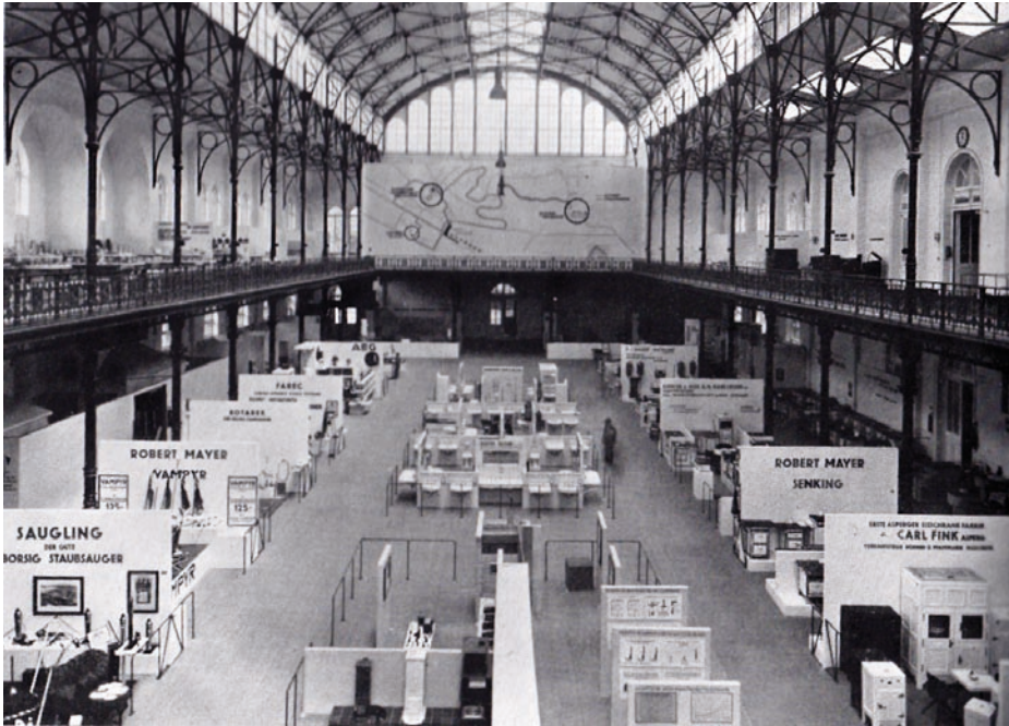
Abb. 5.1.1: Blick in die Gewerbehalle (Halle 1) zur Stuttgarter Ausstellung Die Wohnung , 1927.
