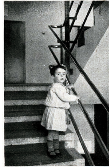
Bild 102. Treppengeländer in den Häusern von Mies van der Rohe. Der zweite Handläufer dient als „Kinder- geländer“.
