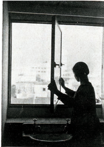
Bild 101. Haus Le Corbusier. Drehfenster, das leicht zu reinigen ist.
