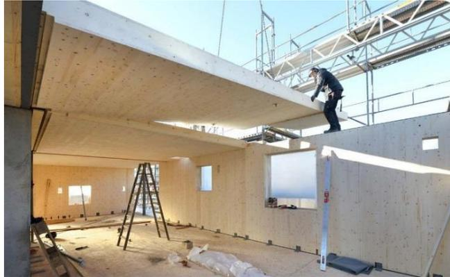
Abbildung 3 Montage Deckenelement
