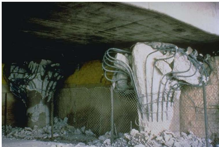
Bild 1.1: Kollabierte Stahlbetonstützen einer Brücke (Foto: M. CELEBI [39])
