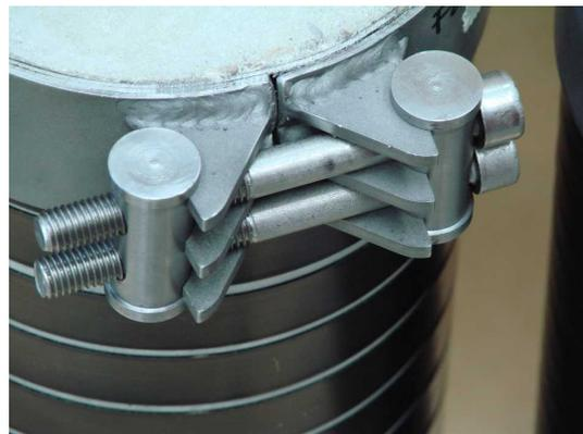
Bild 3.8: Detail einer montierten Verankerungsschelle
