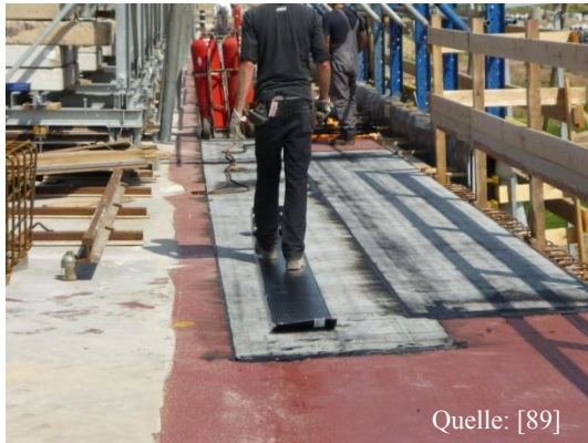
Abbildung 94: Auslegen der Schweißbahn
