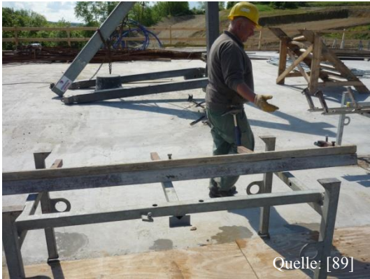
Abbildung 124: Vormontage Schrammborde
