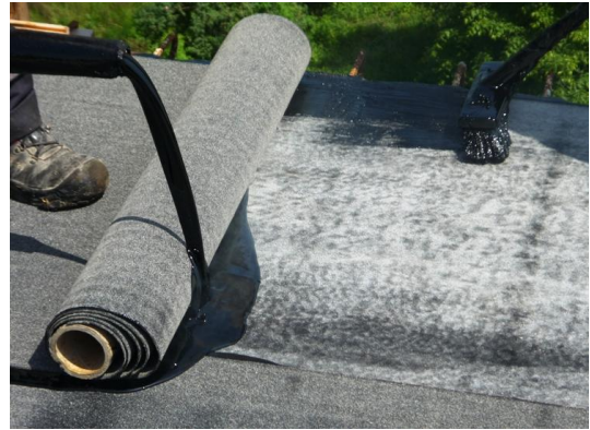
Abbildung 15: Verkleben der Schutzlage [90]
