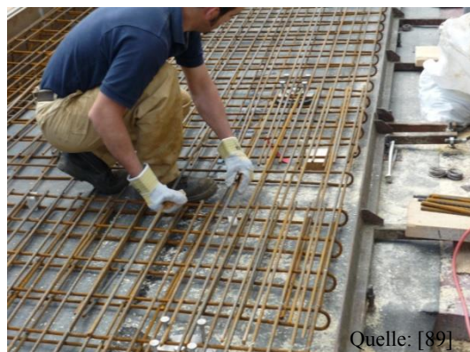
Abbildung 119: Einbau Abstandhalter
