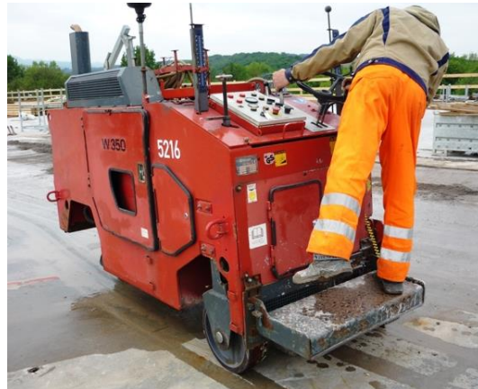
Abbildung 12: Fräsvorgang [90]
