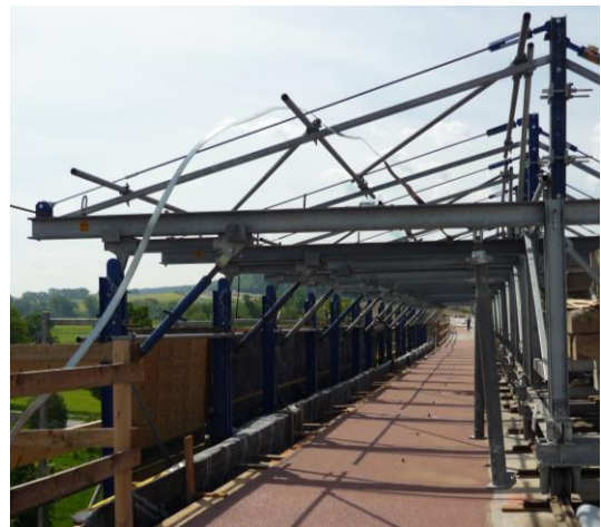
Abbildung 16: Montage Kappenschalwagen [90]
