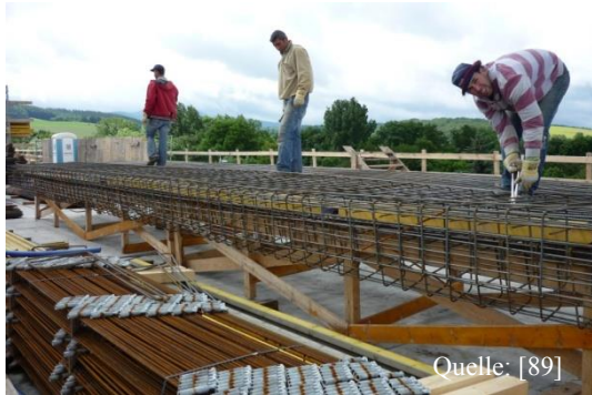
Abbildung 115: Flechten der Bewehrungskörbe
