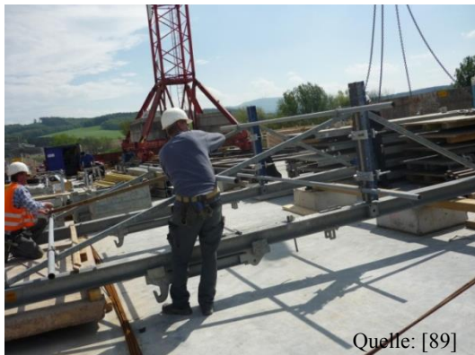
Abbildung 106: Montage der Ausleger
