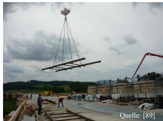
Abbildung 140: Umlagerung Schienen
