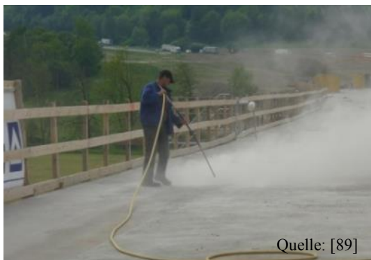
Abbildung 55: Abstrahlen des Untergrundes
