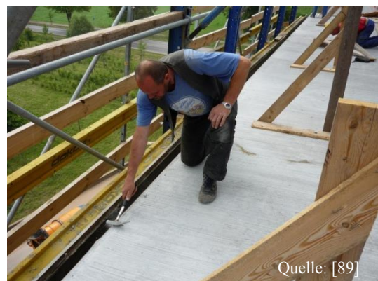
Abbildung 137: Freiklopfen KSW
