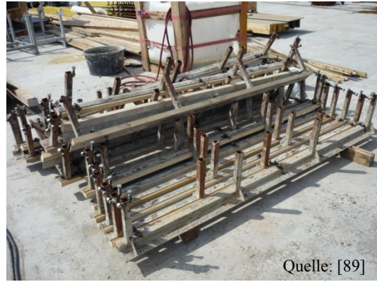
Abbildung 125: vormontierte Schrammborde
