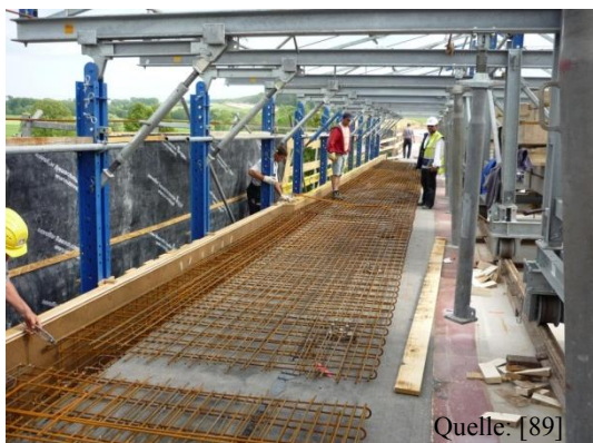
Abbildung 118: Einbau Bewehrung
