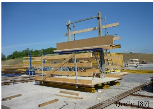
Abbildung 109: montagefertige Hängeeinheit
