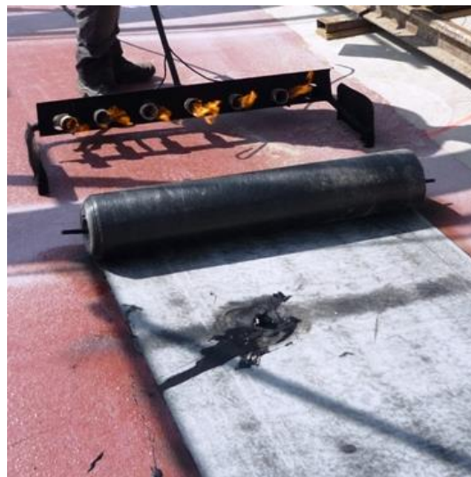
Abbildung 14: Verkleben der Schweißbahn [90]
