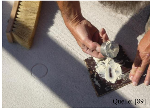
Abbildung 60: Kleber auf Stempel auftragen
