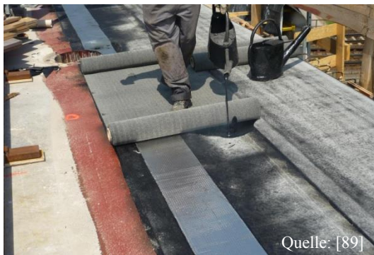
Abbildung 101: Verkleben der Schutzlage
