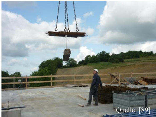
Abbildung 112: Transport der Bewehrung
