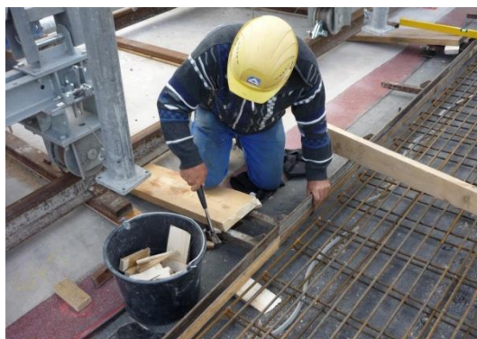
Abbildung 128: Einbringen der Keile
