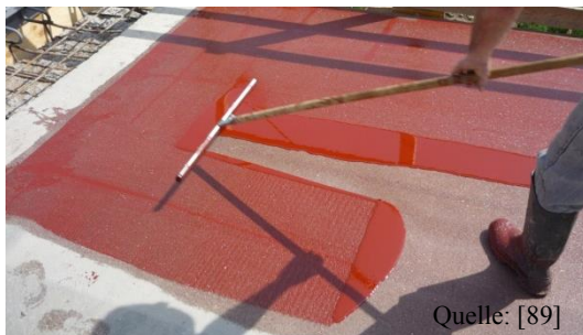
Abbildung 80: Verteilung der Versiegelung
