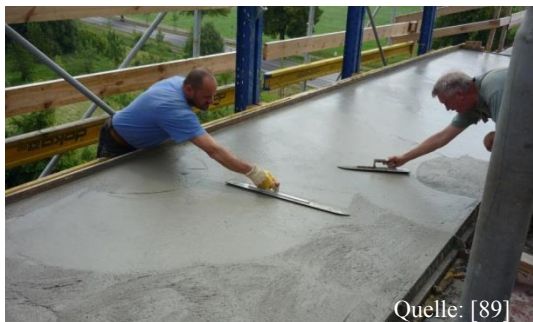
Abbildung 134: Glätten der Betonoberfläche
