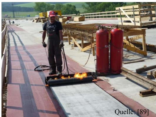
Abbildung 91: Verschweißen der Schweißbahn
