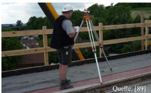
Abbildung 111: Ausrichten des KSW
