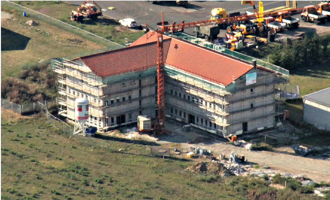
Abbildung 38: Ärztehaus im Bau
