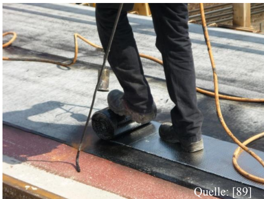
Abbildung 96: Verschweißen der Schweißbahn
