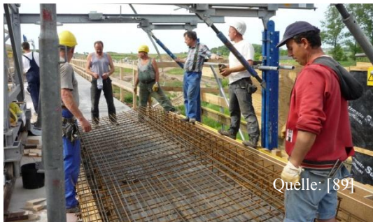
Abbildung 117: eingehobene Bewehrung
