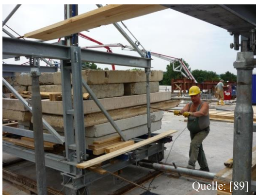
Abbildung 136: Absenken KSW
