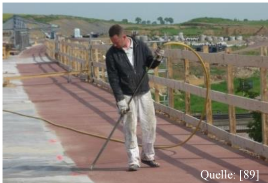
Abbildung 78: Entfernung des überschüssigen Sandes
