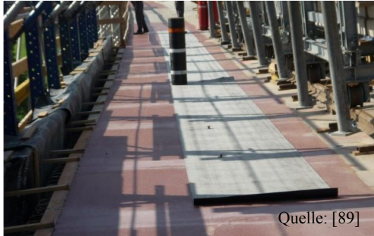
Abbildung 87: Ausrollen der Schweißbahn
