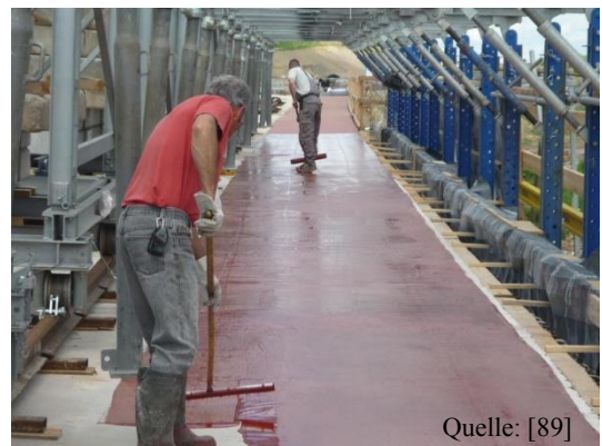
Abbildung 76: Ausrollen der Grundierung
