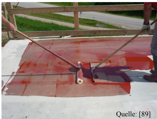
Abbildung 75: Verteilen + Ausrollen
