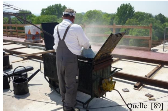
Abbildung 100: Erhitzung des Bitumens
