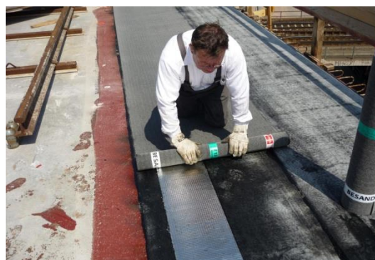
Abbildung 98: Ausrollen der Schutzlage
