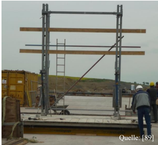
Abbildung 108: Vormontage der Hängeeinheit
