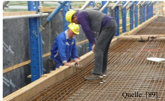
Abbildung 121: Einbau Anker
