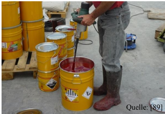
Abbildung 72: Mischvorgang
