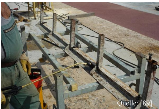
Abbildung 126: Einölen der Schrammborde
