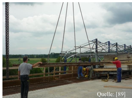
Abbildung 141: Ablassen der Schienen
