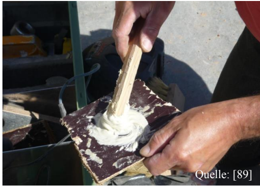
Abbildung 59: Kleber vorbereiten
