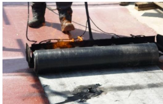
Abbildung 90: Schweißvorgang
