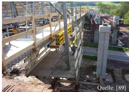
Abbildung 110: montierte Hängeeinheit
