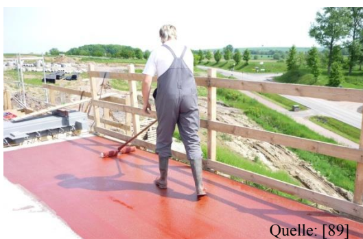
Abbildung 81: Ausrollen der Grundierung
