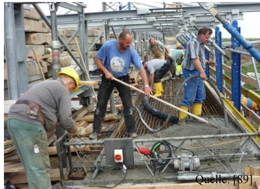
Abbildung 133: Betonverteilung
