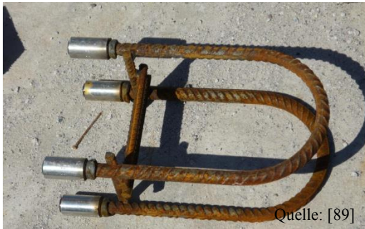
Abbildung 120: Anker Lärmschutzwand
