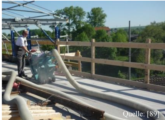
Abbildung 54: Kugelstrahlen
