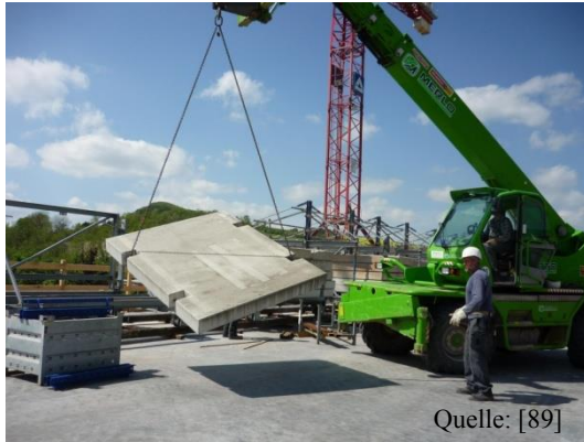
Abbildung 104: Umlagerung der Ballastierung
