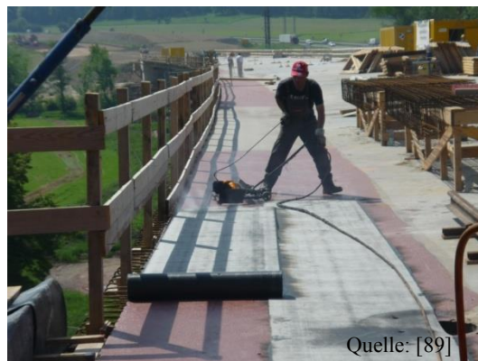
Abbildung 92: Überlappung der Schweißbahnen
