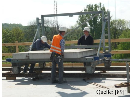
Abbildung 105: Auflegen der Ballastierung
