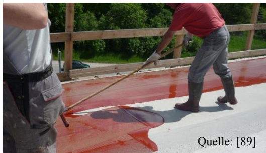
Abbildung 74: Verteilung mit Abzugsgerät
