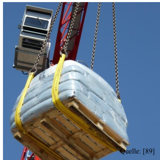
Abbildung 86: Materialtransport mit Hochbaukran
