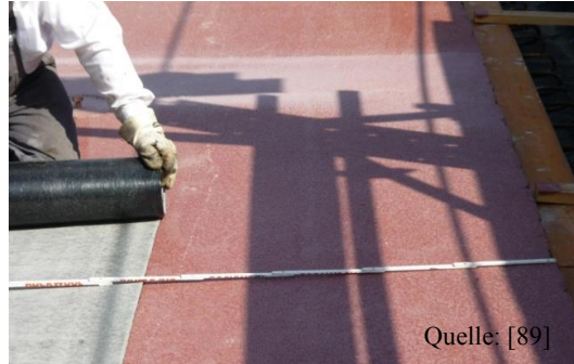
Abbildung 88: Ausrichten der Schweißbahn
