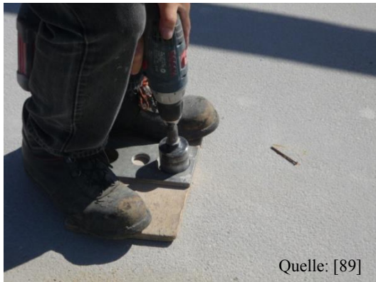
Abbildung 56: Vorbohren von Löchern
