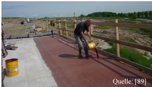
Abbildung 79: Auftrag der Versiegelung
