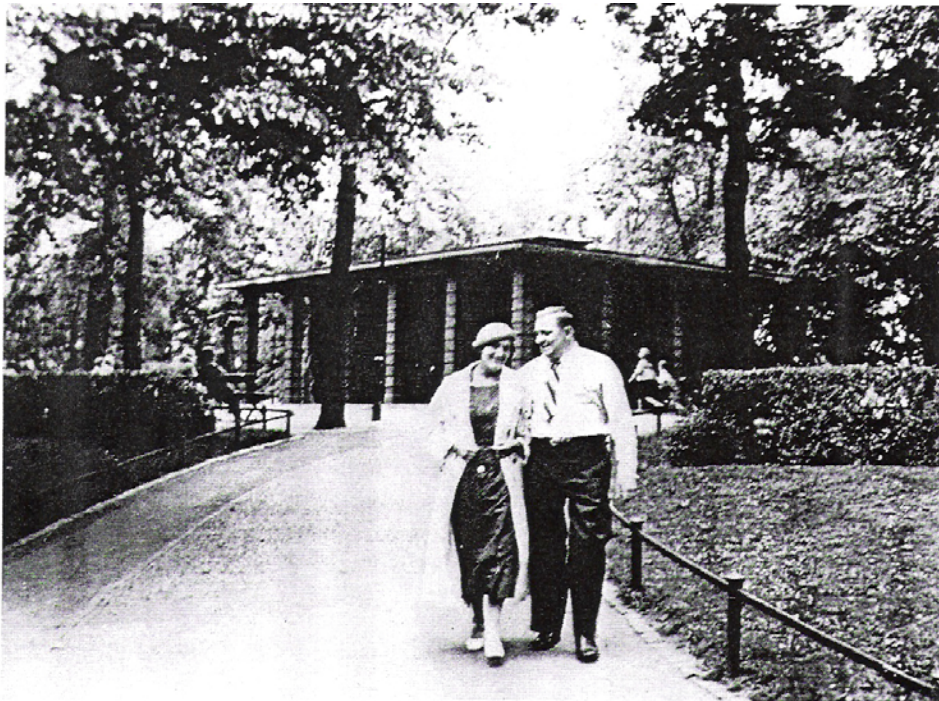
Trafohaus Helmholtzplatz, ca. 1940 Foto: anonym
