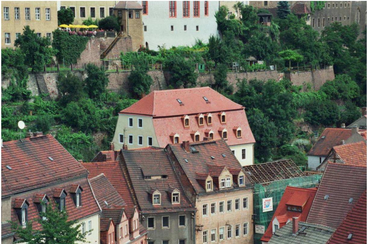
Abb. 347: Löthainer Hof im Bau, Hauptgebäude fertiggestellt 1996
