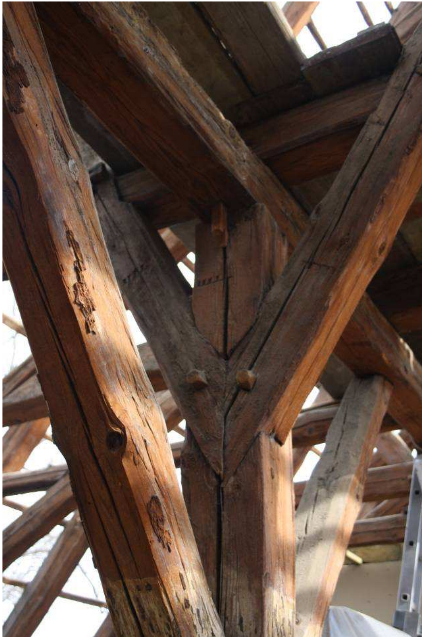
Abb. 322: Freiheit 12, Detail des gotischen Dachwerkes: Stuhlsäule in Binderebene
