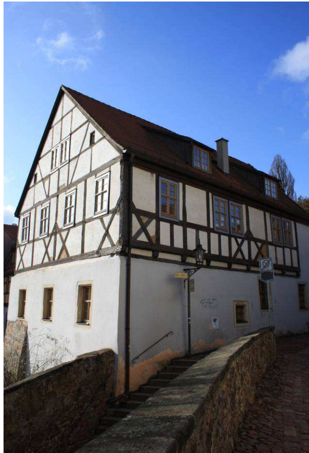
Abb. 309: Freiheit 4 von der Straße zur Schloßbrücke
