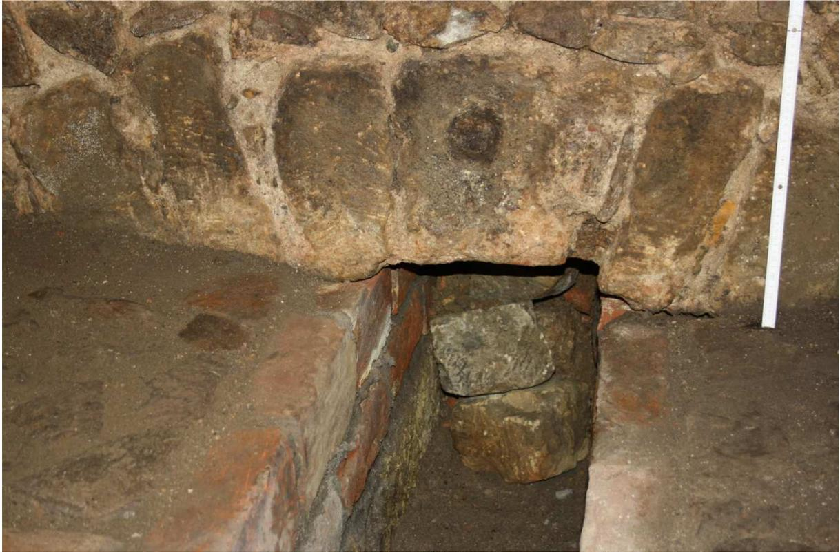
Abb. 264: Webergasse 1: Überwölbter Röhrenwasserauslauf mit Markierungsloch
