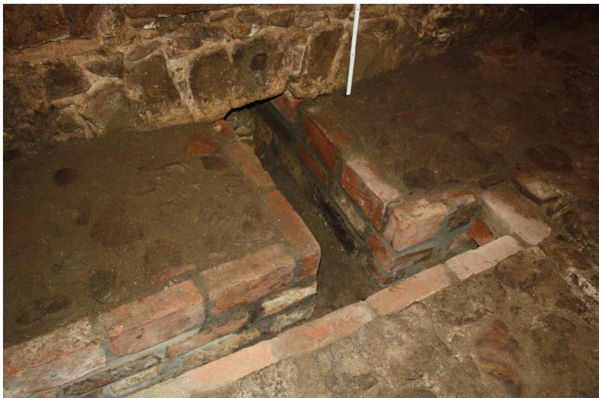
Abb. 263: Webergasse 1, Auslauf des Röhrfahrtwassers im gemauerten Kanal
