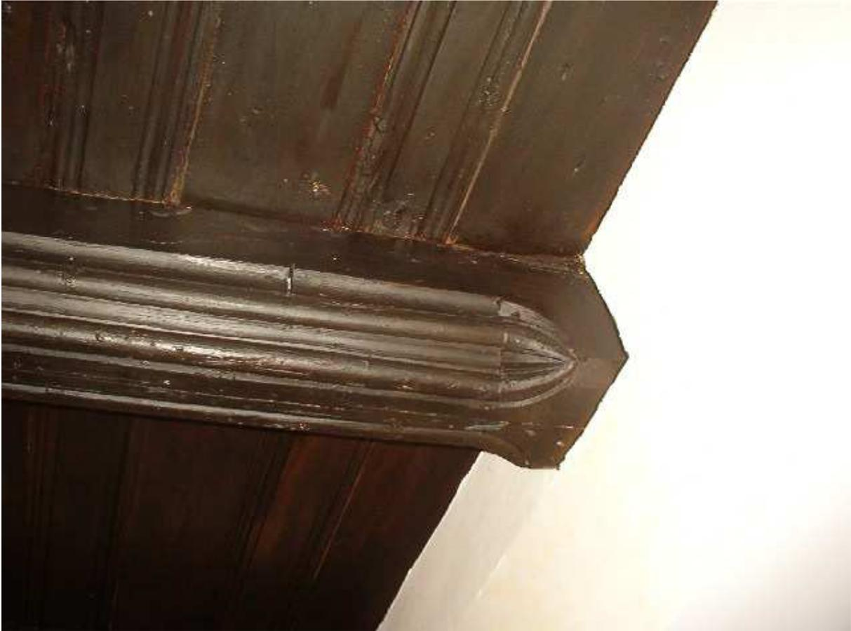
Abb. 61: Holzbalkendecke über der Ladenstube im Erdgeschoss, profilierter Balkenkopf
