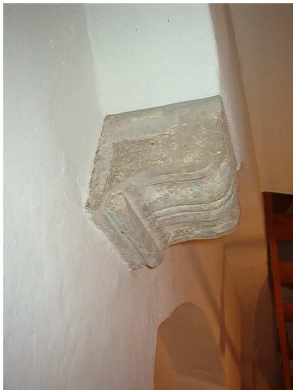
Abb. 62: Volutenkonsole im Vorraum Obergeschoss, Sandstein
