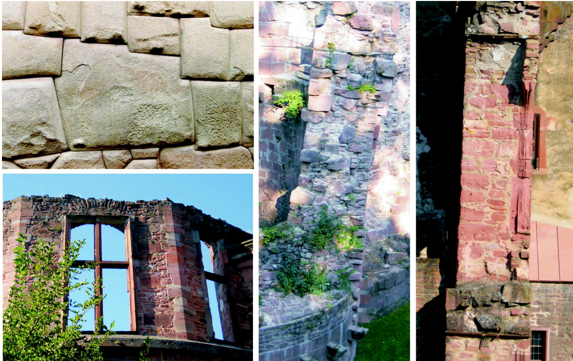
Abbildung 8.2: Beispiele für unterschiedliche Ausführungen von historischem Mauerwerk
