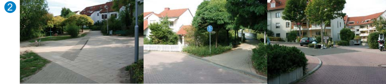
Geschosswohnen ,Carl-Sonnenschein-Siedlung' | Typische Großsiedlung der sechziger Jahre
