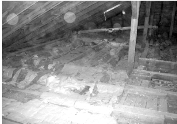
Bild 5 Mineralwolle-Matten im Spitzbodenbereich
