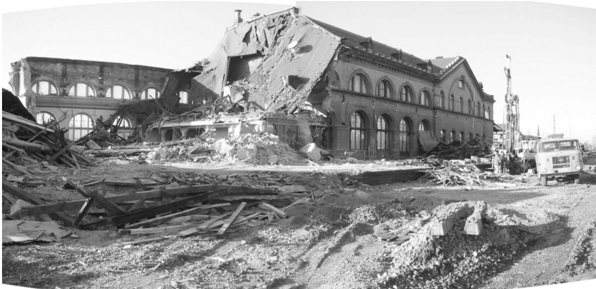
Bild 3 Maschineller Abriss des Inselgebäudes (eine Hälfte ist bereits abgerissen)
