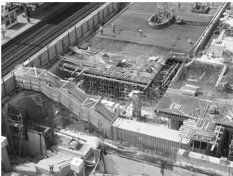
Bild 4 Das Bahnhofsgebäude (eigentlich Brückenbauwerk) wird erstellt
