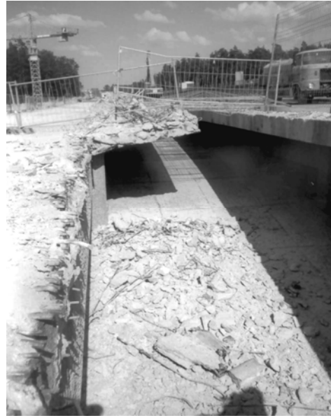
Bild 13 Rückbau der inneren Kragarme über die Holzabdeckung
