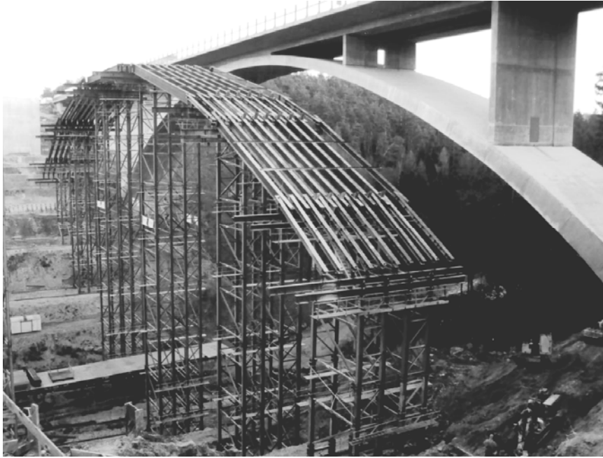
Bild 28 Gerüst für den Neubau; der Bogen ist komplett abgebrochen
