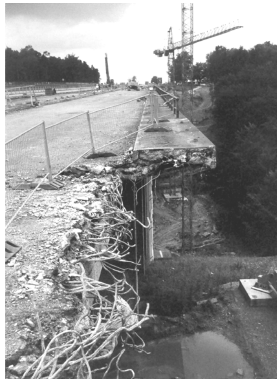
Bild 11 Rückbau der Kappen am Widerlager Ost
