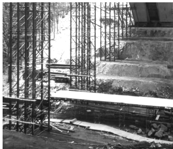
Bild 6 40 m langer Fußgängertunnel über dem Teufelstalweg
