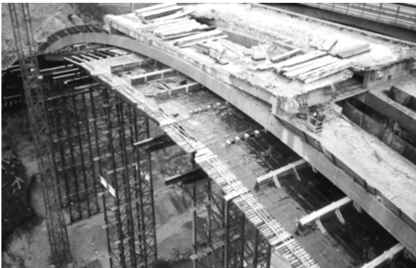
Bild 22 Gerüstverzug unter den Bogen
