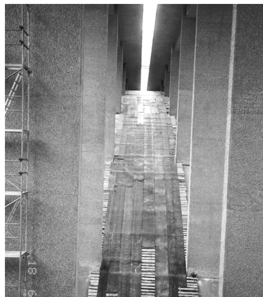
Bild 8 Kanthölzer als Schutzeinrichtung zwischen den Bögen
