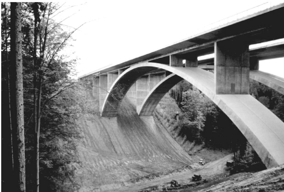
Bild 29 die zwei neuen Brückenbauwerke über dem Teufelstal
