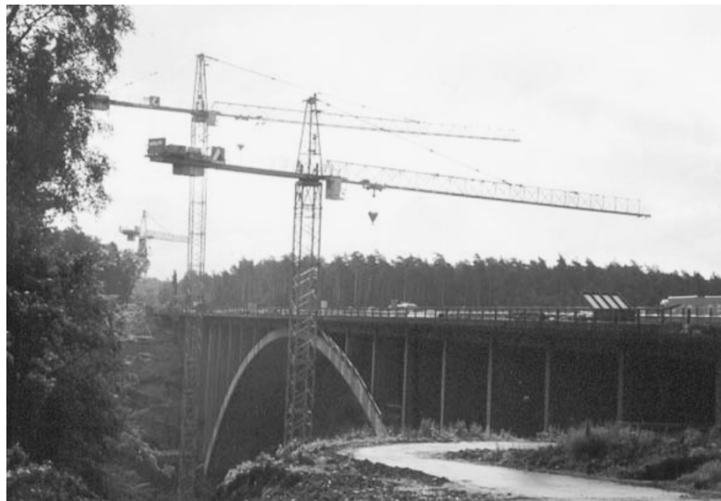
Bild 7 beeindruckende Krankulisse an der Teufelstalbrücke
