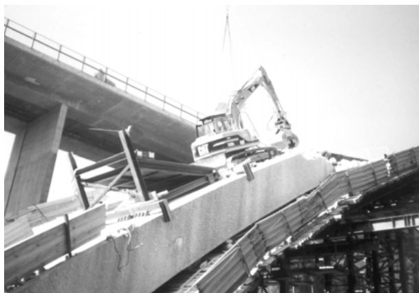
Bild 26 Bagger im Einsatz (im Vordergrund: temporäre Arbeitsebene)
