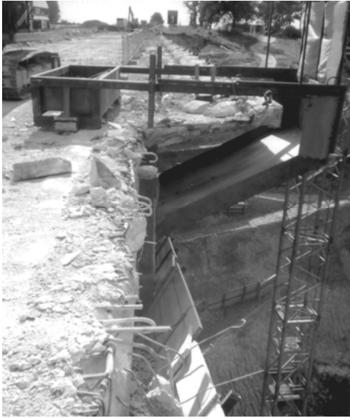
Bild 12 Rückbau der äußeren Kragarme über eine Rutsche
