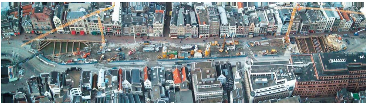
Bild 2 Baustellenbild Amsterdam (Quelle: Max Bögl Bauunternehmung GmbH)
