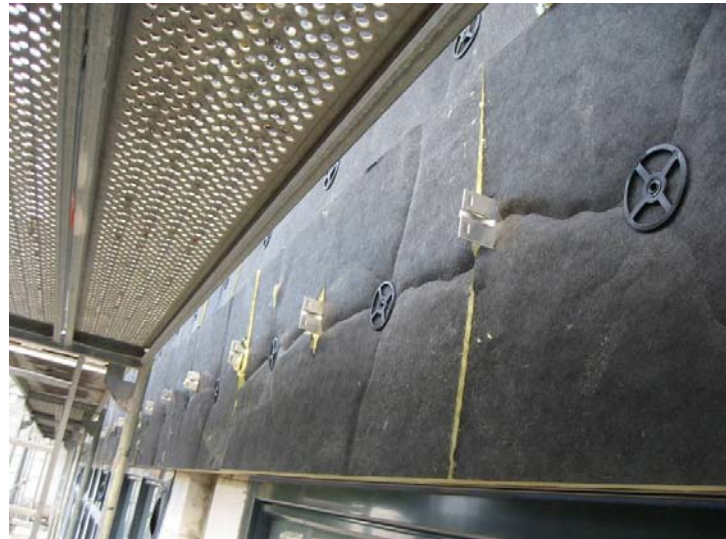
Bild 14 Montage der Wärmedämmplatten
