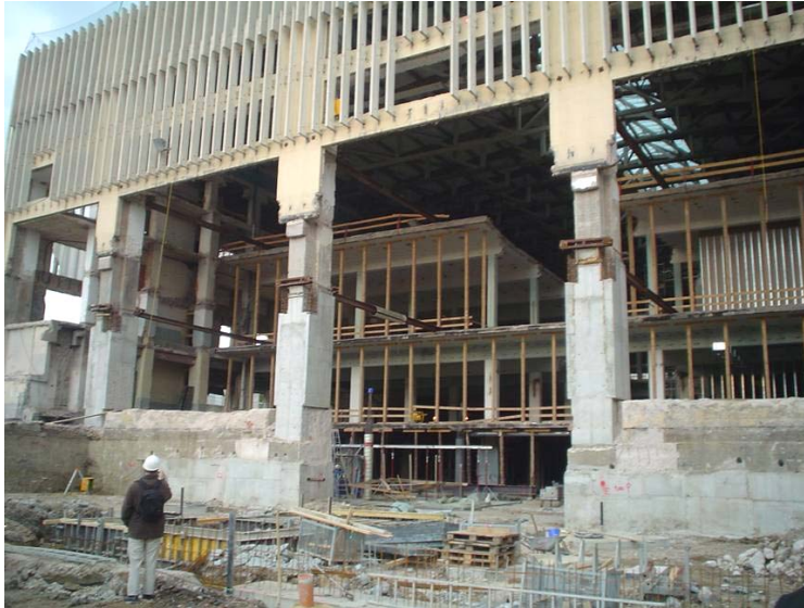
Bild 5 Umbau Weimar Atrium, Entkernung und neue innere tragende Struktur
