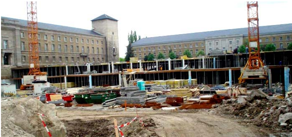
Bild 10 Baustelle doppelstöckige Tiefgarage Atrium Weimar
