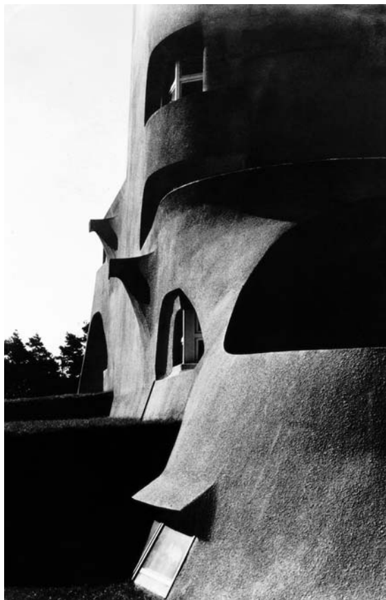
4 | Arthur Köster, Nordostdetail des Einsteinturmes von Erich Mendelsohn, 1922/23
