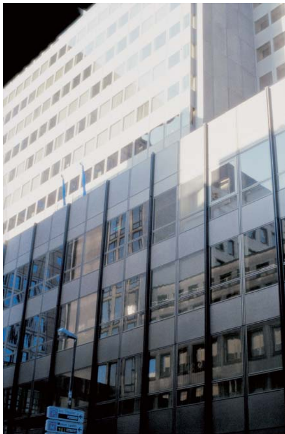
6 | Richard Heil, Gebäude der Commerzbank („Commerzbank-Bronzeturm“) in Frankfurt/Main, 1970–74
