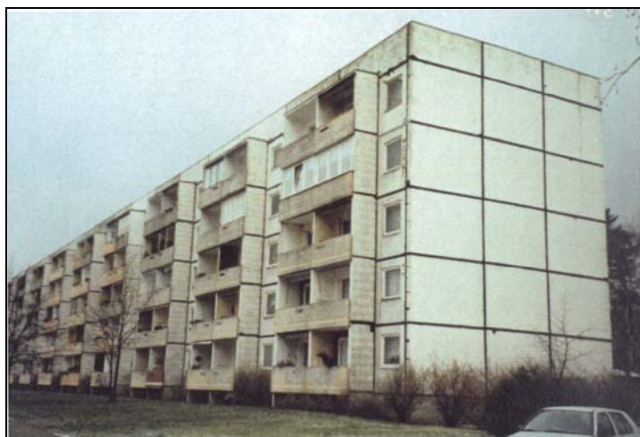
Bild 6: Plattenbau, Typ P 2, 5geschossig [6]
