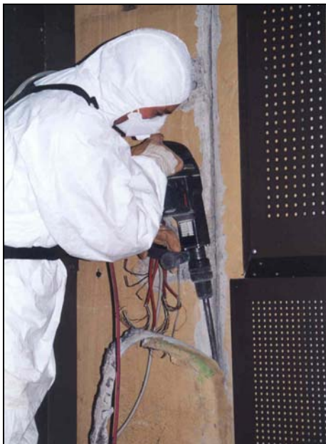
Bild 30: Ausstemmen des Fugendichtstoffes
