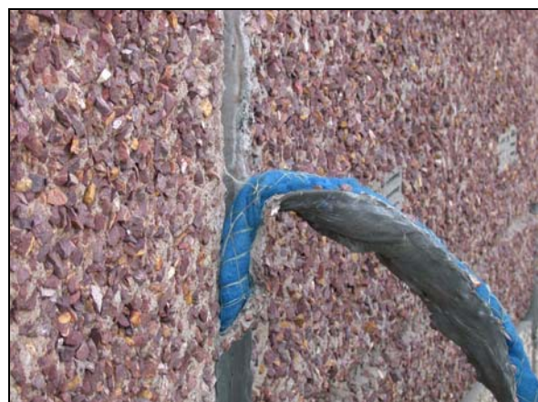
Bild 58: Morinol und Hinterfüllmaterial
