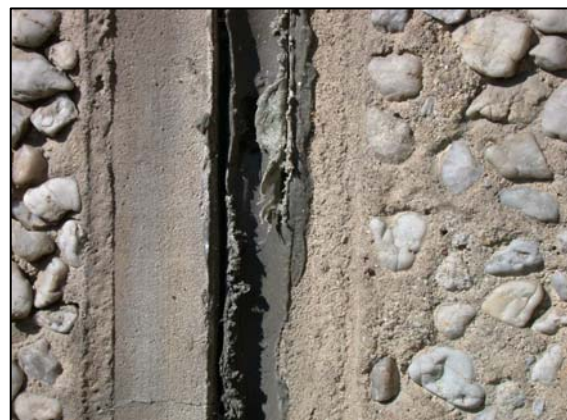
Bild 45: Fuge nach der Bearbeitung
