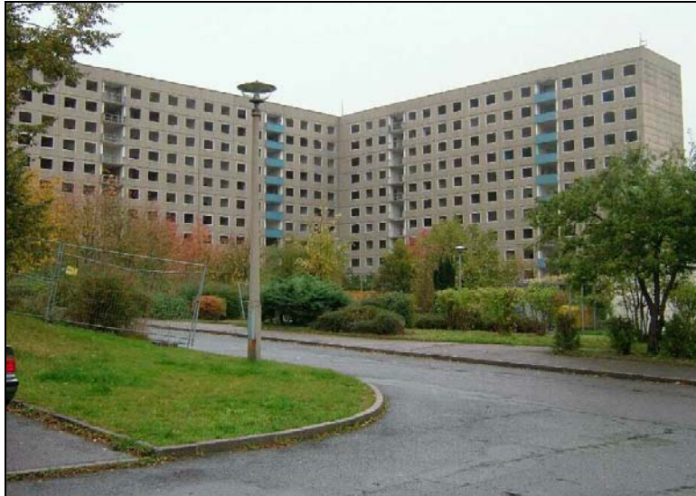
Bild 3: Wohnblock mit Morinol Fugendichtung in Jena
