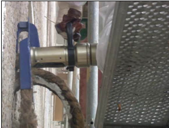
Bild 59: Erprobung vom Gerüst
