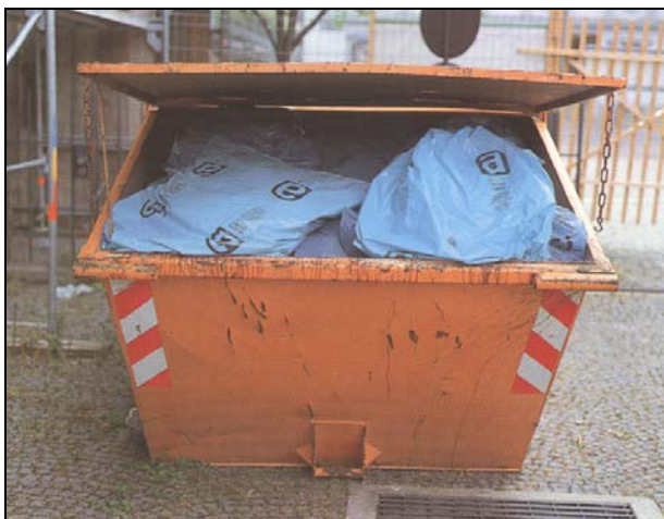
Bild 24: Verschließbarer Baustellencontainer mit gekennzeichneten Kunststoffsäcken [19]
