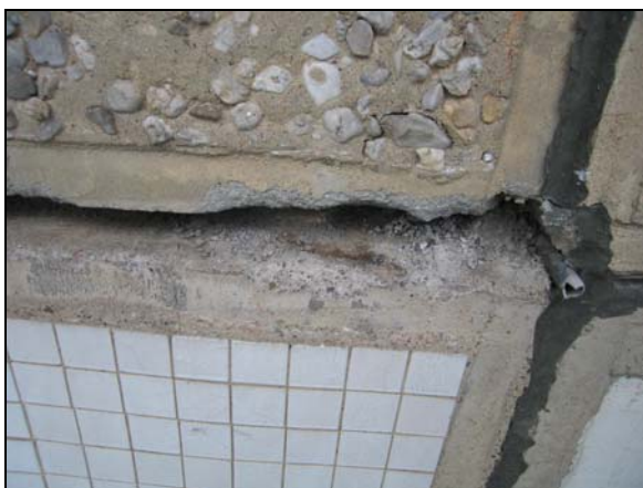
Bild 57: Fuge ohne Dichtstoffreste
