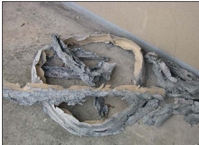
Bild 26: Ausgebauter Fugendichtstoff Morinol
