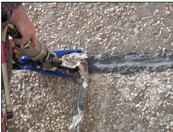
Bild 55: Erprobung - Horizontalfuge
