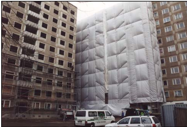
Arbeitsgerüst mit und ohne Schutzfolie
