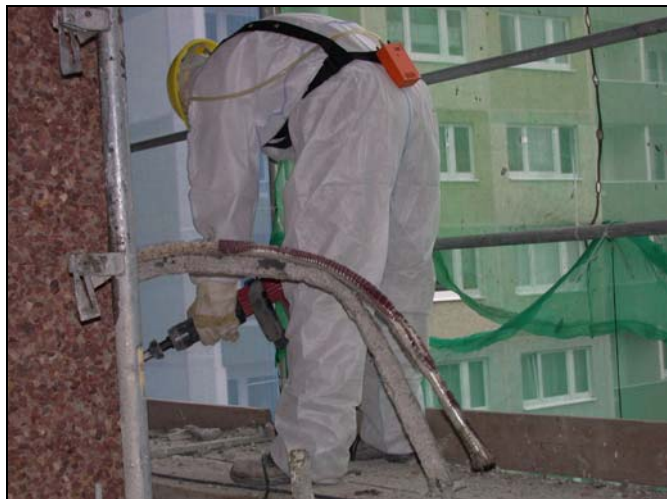
Bild 31: Gemeinsamer Ausbau von Fugendichtstoff und Dichtstrick
