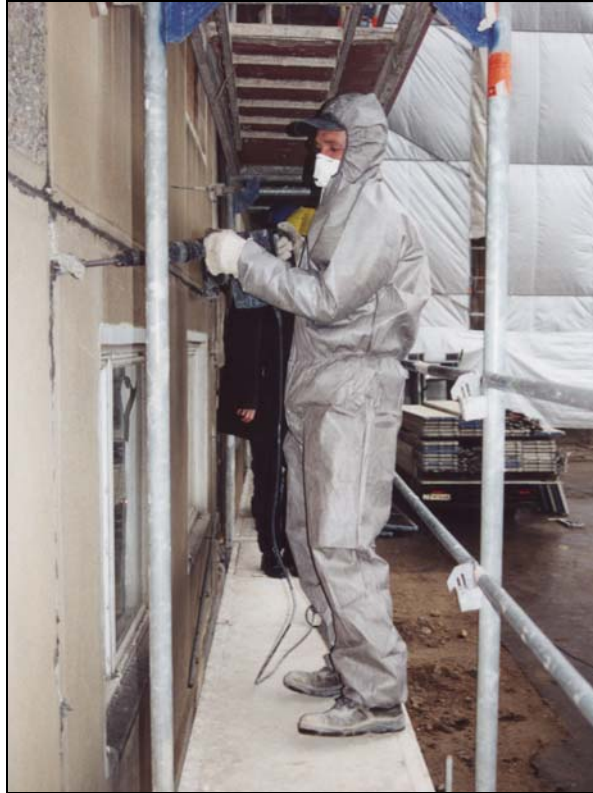
Bild 4: Ausstemmen des Fugendichtstoffes
