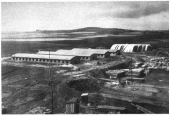
41 Die Baustelle der AVIA-Flugmotorenwerke in Prag-Letňany am 28.7.1942, Die Kantine im Bau Quelle: Werkarchiv der AVIA-Werke, Prag
