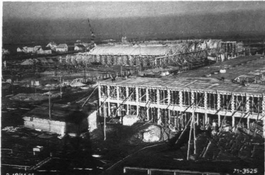
3) Die Baustelle der AVIA-Flugmotorenwerke in Prag-Letňany am 19.11.1941, im Bau eine Produktionshalle und die Härtereie, im Vordergrund ist der Schatten des Wachturms erkennbar, Quelle: Werkarchiv der AVIA-Werke, Prag
