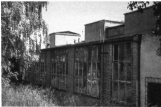
51 AVIA-Flugmotorenwerke in Prag-Letňany, Motorenprüfstandsgebäude, 1943, Zustand 1994, Quelle: Foto: Olaf Bartels
