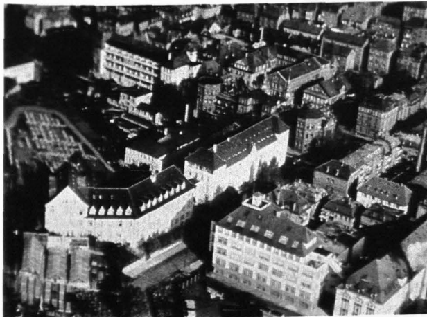
9 Kann ich die Altsubstanz so adaptieren, daß ich mit neuen Technologien auch einziehen kann? Bekomme ich wegen der Zu- und Ablieferungen Schwierigkeiten mit den Anrainern?
