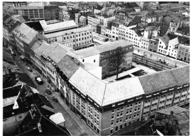
4 Gera, Innenstadt. Beispiel: für den innerstädtischen Wohnungsbau der 80er Jahre
