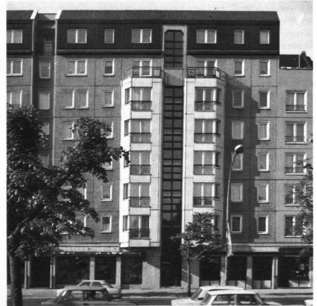
2 Frankfurter Allee Süd – 1. Quartier: Betonung des Treppenhauses am modifizierten 24 m Segment
