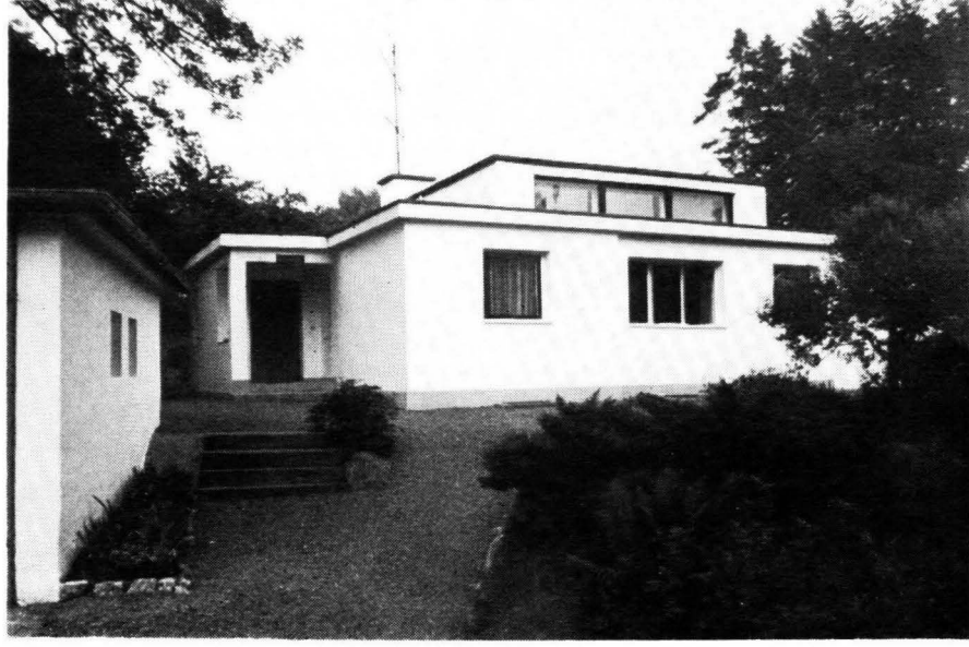
2 Das rekonstruierte Musterhaus Am Horn der Bauhaus-Ausstellung vom Sommer 1923. Im Mittelraum des Gebäudes wurde eine neugestaltete Kabinettausstellung eröffnet
