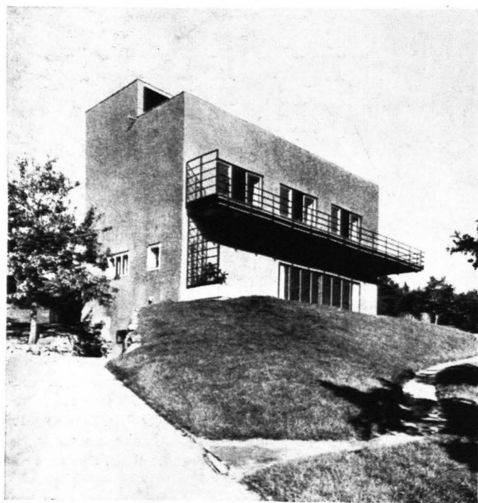
21 Otto Eisler: Eigenes Haus in Brno, 1930
