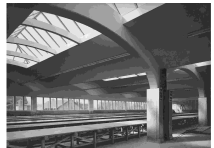
Abb. 94 Tonnengebäude PAUSA Oberlichthalle
