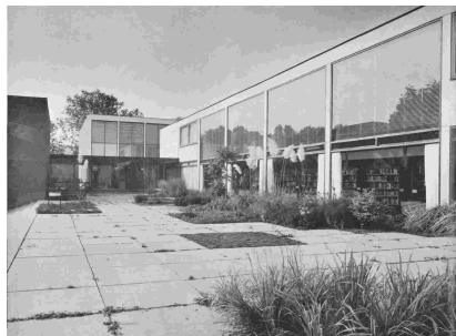
Abb. 37 Eingangsbereich Reuchlinhaus, rechts der Büchereiflügel
