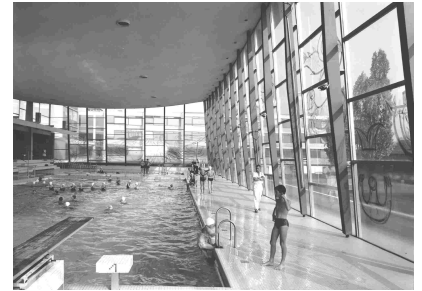
Abb. 191 Stadtbad Stuttgart-Feuerbach Verbindung von Kunst und Alltag, auf der Glasfassade Glasmalerei von HAP Grieshaber „O Du mein Neckar“
