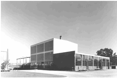
Abb. 96 Kesselhaus, Werkstätten, Kantine im Herzen der PAUSA AG
