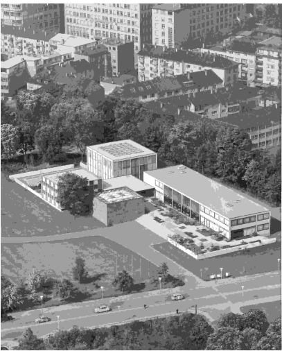
Abb. 193 Reichlinhaus Pforzheim aus der Luft, Zustand, wie er auch heute noch besteht
