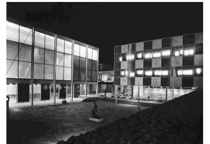
Abb. 156 Reuchlinhaus Pforzheim Gartenhof
