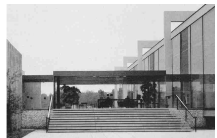
Abb. 65 Eingangstreppe Wilhelm Lehmbruck Museum
