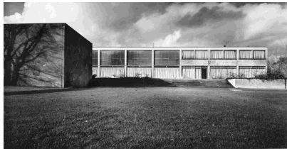
Abb. 36 Ansicht Reuchlinhaus vom Stadtspark mit Treppe
