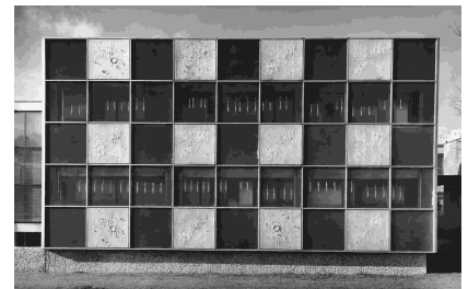
Abb. 49 Die aus Rohglasplatten und Aluminiumplatten bestehende Fassade des Schmuckmuseums
