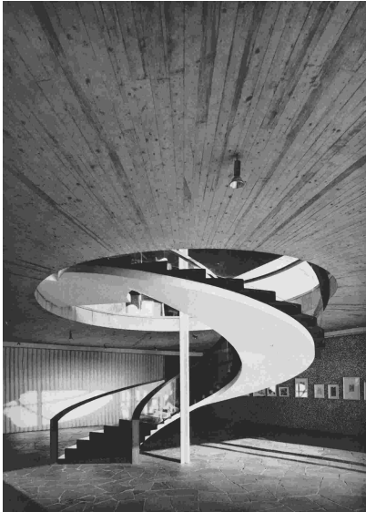
Abb. 41 Die freitragende Wendeltreppe der zentralen Eingangshalle vom Untergeschoß aus gesehen
