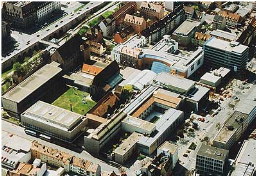
Abb. 19 Germanisches Nationalmuseum Nürnberg Den architektonischen Kern bildet ein spätmittelalterliches Kartäuserkloster. Das äußere Erscheinungsbild prägen die Bauten von Sep Ruf aus den 50er und 60er Jahren (links unten) sowie 1993 entstandene Gebäude.
