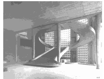
Abb. 162 Freitragende gebogene Treppe im Musée des Travaux Publics
