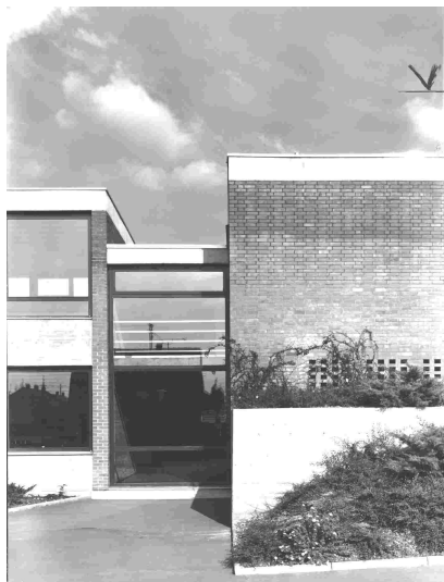
Abb. 121 Realschule Mössingen von Osten, wie schon bei der Grundschule verwendet Manfred Lehmbruck auch hier Ziegelmauerwerk an der Fassade
