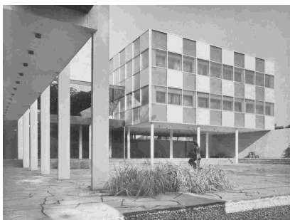
Abb. 186 Tiefhof des Reuchlinhauses
