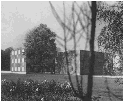
Abb. 229 Reuchlinhaus Pforzheim, das Heimatmuseums zeigt seine Heimatverbundenheit durch die Verkleidung mit heimischen Sandstein, wohingegen das Schmuckmuseum Metall, Schmelze und Brillanz mittels der Fassade aus Metall- und Rohglasplatten zum Thema macht
