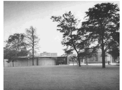
Abb. 5 Wilhelm-Lehmbruck-Museum Duisburg, Ansicht vom Park
