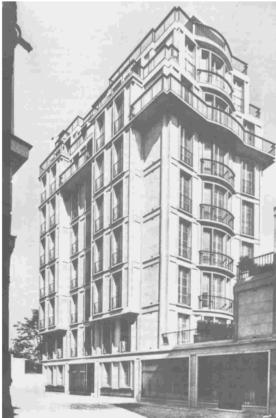
Abb. 159 Auguste Perret, Apartmenthaus Paris, 25 Rue Franklin
