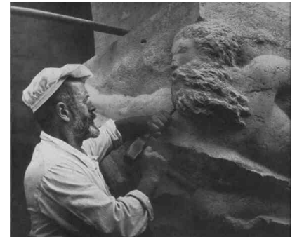
Abb. 153 Paul Bonatz, Rudolf Christ, Kunstmuseum Basel, individuelle Steinmetzarbeiten an Kapitell der Kollonaden
