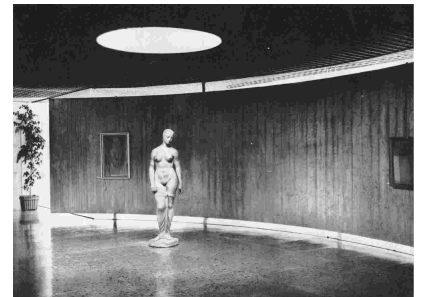
Abb. 189 Wilhelm Lehmbruck Museum Duisburg Aufständigung von Wandscheiben im Plastikmuseum lassen diese schwebend erscheinen
