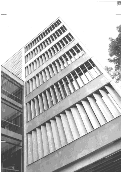
Abb. 105 Berufsschule Feuerbach Spezialklassentrakt mit verstellbaren Lärm- und Lichtschutzlamellen
