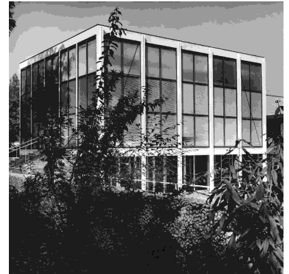
Abb. 53 Fassade der Ausstellungshalle
