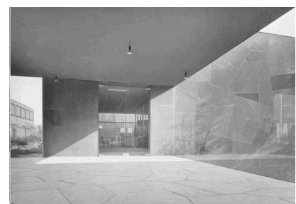
Abb. 45 Die Fassadenverkleidung des Heimatmuseums mit Sandstein setzt sich im Inneren fort, kaum unterbrochen durch die große Glasscheibe der Verglasung der Eingangshalle (beginnend am rechten Bildrand)
