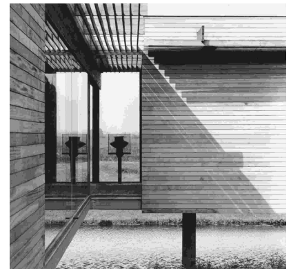
Abb. 213 Federseemuseum Bad Buchau, die vertikale Verschattung schützt vor unangenehmer Blendwirkung und Aufheizung durch direkte Sonneneinstrahlung
