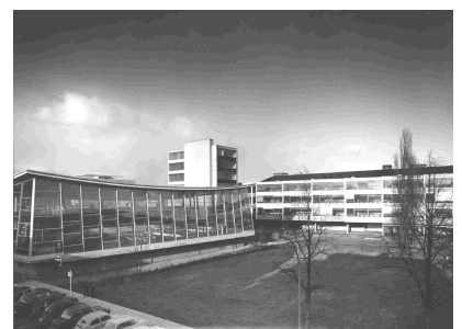
Abb. 8 Berufsschule und Stadtbad Stuttgart-Feuerbach, Blick auf Halle, im Hintergrund die Berufsschule
