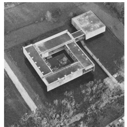
Abb. 85 Federseemuseum Bad Buchau, von rechts unten erschließt der Steg die Eingangshalle, die die beiden Hauptgebäudeteile verbindet: das Museum um den Innenhof mit der als Hochmoor angelegten Insel im künstlichen See und der biologischen Forschungsstelle. Links ist der Zugang zum Federseesteg zu sehen.
