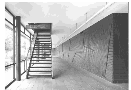
Abb. 108 Schwimmhalle Feuerbach Eingangsbereich, Wand mit Keramiksteinen
