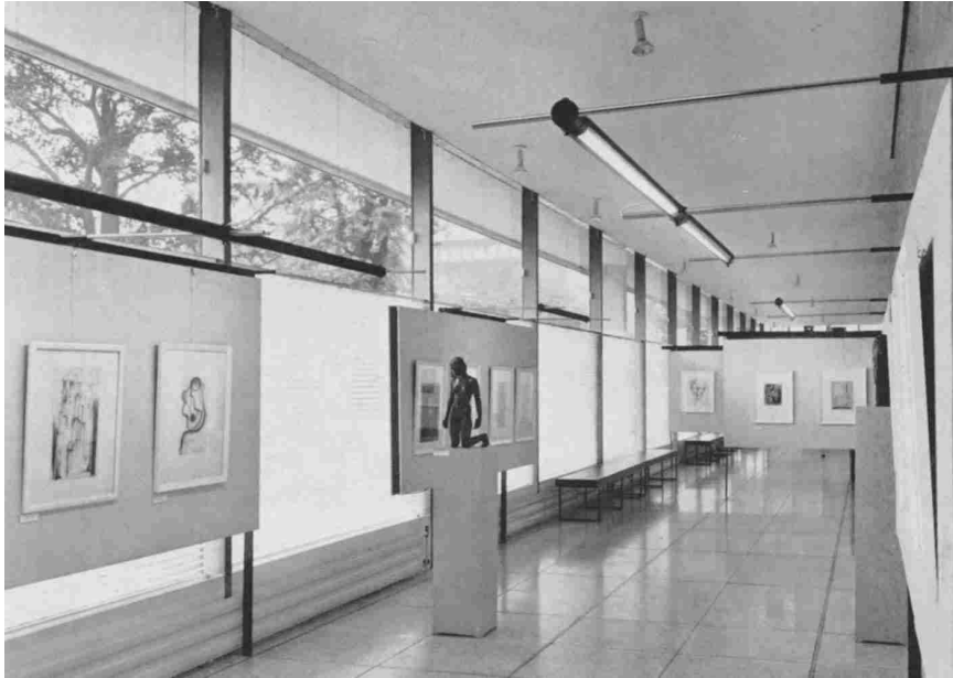
Abb. 219 Wilhelm-Lehmbruck-Museum Duisburg, die Besonderheit in dieser Abteilung der Ausstellungshalle sind die von unten nach oben fahrenden Jalousien; dadurch lässt sich eine glatte, das Licht gut reflektierende Untersicht der Decken erreichen
