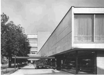
Abb. 103 Stadtbad Feuerbach Eingangsbereich
