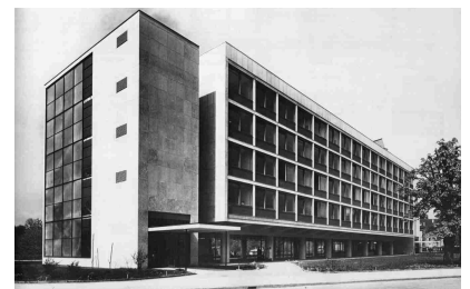
Abb. 100 Hans Brechbühler, Gewerbeschule und Lehrwerkstätten, Bern, Rückfassaden mit den beiden Eingängen, 1935-1939, Manfred Lehnbruck arbeitete im Büro Brechbühler nach dem 2. Weltkrieg für einige Zeit
