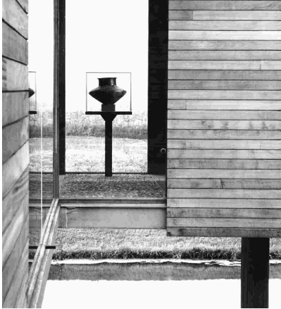
Abb. 86 Federseemuseum Bad Buchau, Blick vom Innenhof durch das Museum hindurch, gut zu erkennen die naturbelassene Afzelia Verschalung
