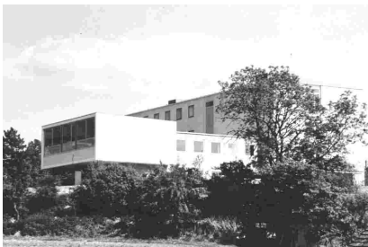
Abb. 247 Kreiskrankenhauses in Ehingen, im Vordergrund der Operationstrakt
