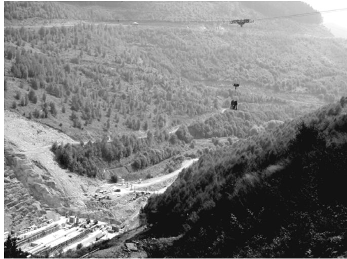
Bild 19 Bauzustand der Talsperre im Jahr 2000 (Blick zu Fundament und Kabelkran)
