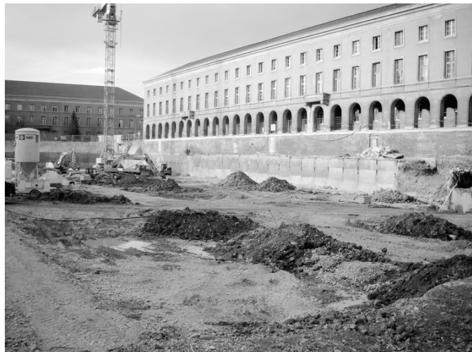
Bild 15 Baustelle Atrium am 10. Januar 2005 (Foto der Projektgruppe)
