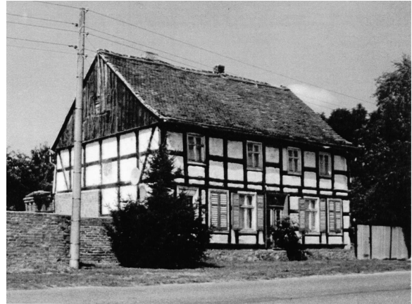
Abb. 51: Wohnhaus Neubarnim, Dorfstr. 25, erbaut um 1780/90
