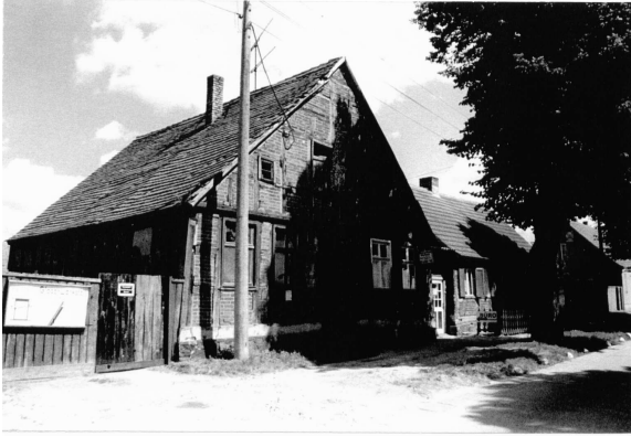
Abb. 33: Giebelständiges Wohnhaus in Neureetz, Ernst-Thälmanstraße 12
