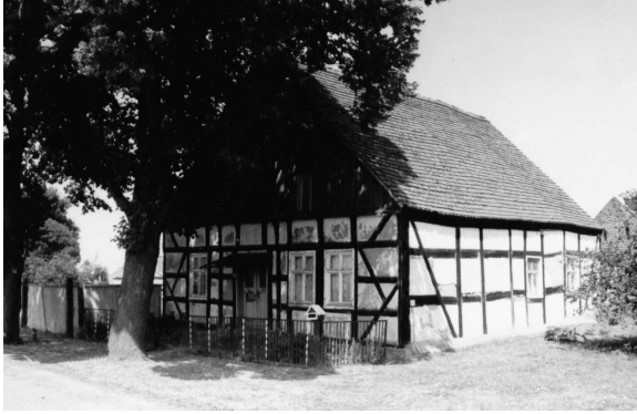
Abb. 47: Wohnhaus eines ehemaligen Häuslers in Klein Neuendorf, erbaut um 1798
