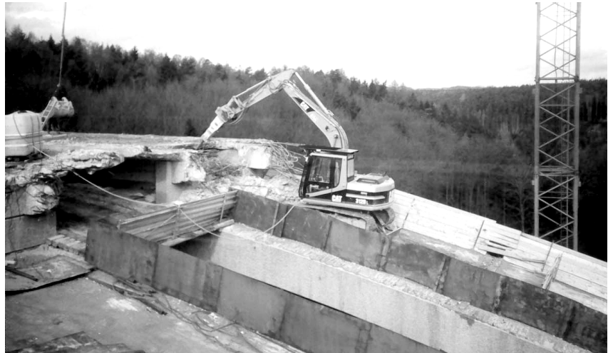
Bild 9 Stahlprofile als Seitenschutz
