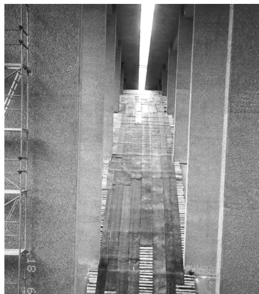
Bild 8 Kanthölzer als Schutzeinrichtung zwischen den Bögen
