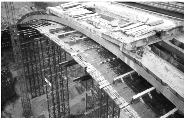
Bild 22 Gerüstverzug unter den Bogen
