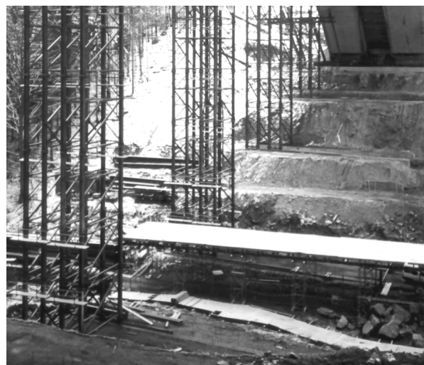
Bild 6 40 m langer Fußgängertunnel über dem Teufelstalweg
