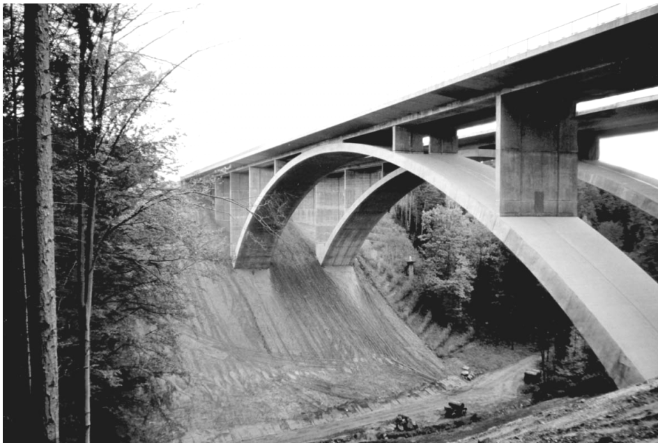
Bild 29 die zwei neuen Brückenbauwerke über dem Teufelstal
