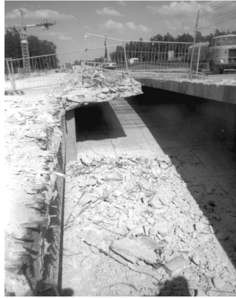
Bild 13 Rückbau der inneren Kragarme über die Holzabdeckung
