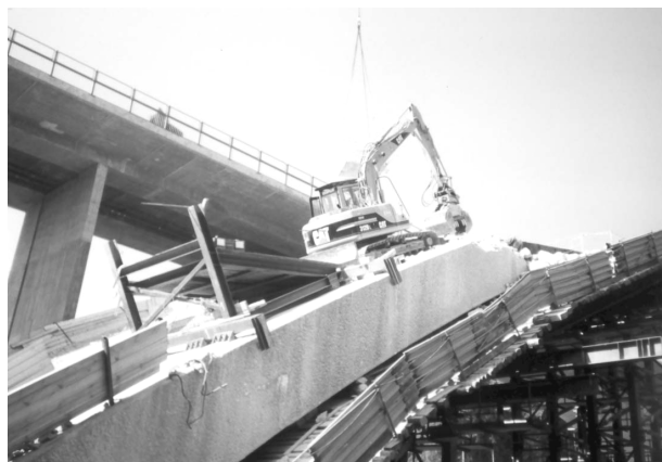
Bild 26 Bagger im Einsatz (im Vordergrund: temporäre Arbeitsebene)
