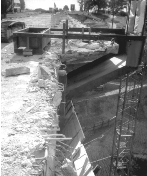
Bild 12 Rückbau der äußeren Kragarme über eine Rutsche
