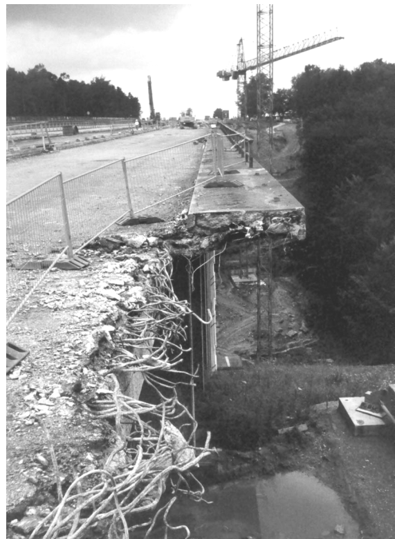
Bild 11 Rückbau der Kappen am Widerlager Ost
