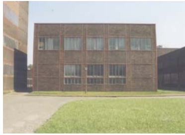
Abb. 9 Foto einer Fassade
