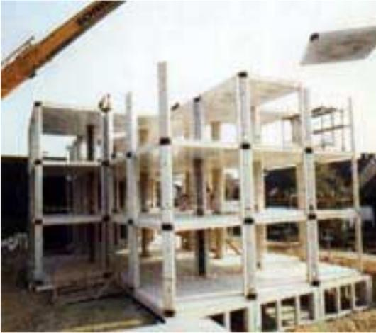
Abbildung 80 IBS-System im Rohbau<sup>480</sup>
