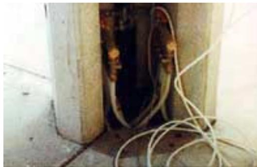
Abbildung 79 Offenes Stützegeviert mit Installationsführung<sup>479</sup>
