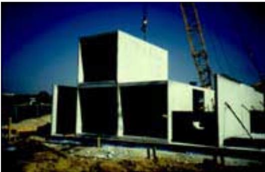
Abbildung 39 34 Reihenhäuser in Raumzellenbauweise, bei der Montage / im fertigen Zustand<sup>239</sup>
