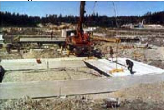
Abbildung 50 Montage vorgefertigter Fundamentwände<sup>275</sup>
