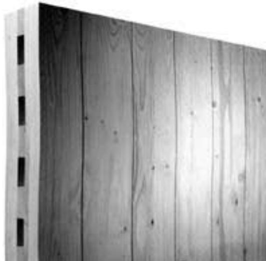
Abbildung 88 Zwischenwand aus Massivholz<sup>507</sup>
