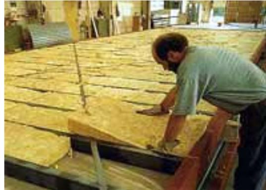
Abbildung 114 Einbringen der Dämmung<sup>593</sup>
