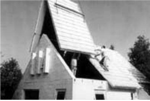
Abbildung 106 Klappdach für ein EFH in Holland<sup>564</sup>
