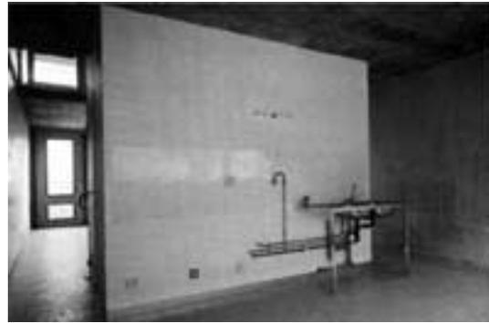
Abbildung 152 AP-Leitungsführung in einer Küche<sup>748</sup>
