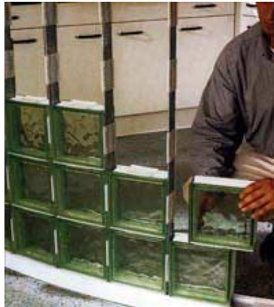
Abbildung 130 Einsetzen der Glassteine
