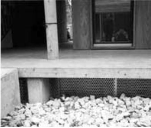
Abbildung 99 BSH-Platten als Erdgeschoßboden
