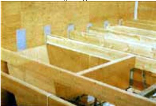
Abbildung 101 Anschluß der Deckenbalken<sup>546</sup>
