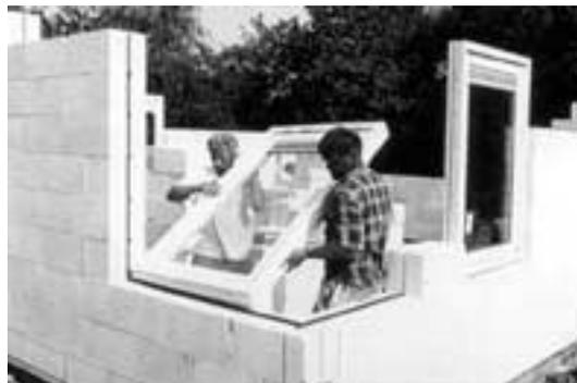
Abbildung 74 Fenstereinbau während des Rohbaus<sup>464</sup>
