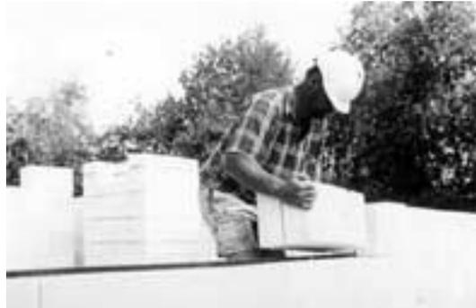
Abbildung 73 Versetzen der Steine<sup>463</sup>
