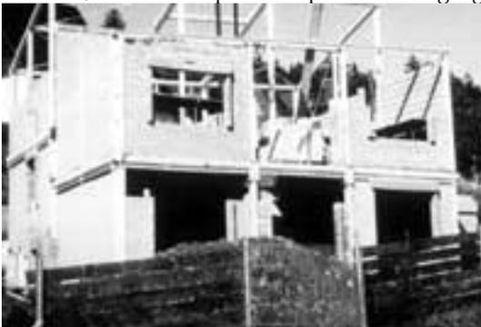
Abbildung 110 Beispiel für ein Wohngebäude in Stahl-Mauerwerksbauweise<sup>582</sup>
