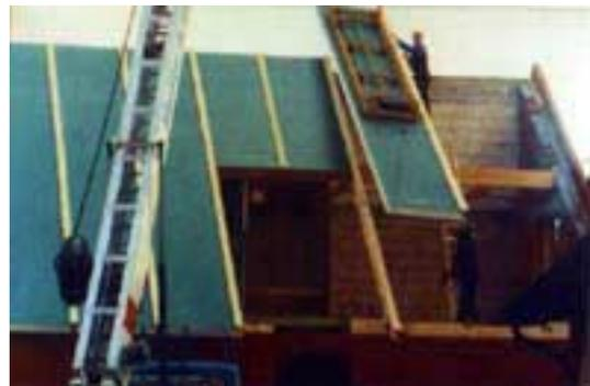
Abbildung 105 Montage eines Dachelements mittels Saugtraverse<sup>563</sup>
