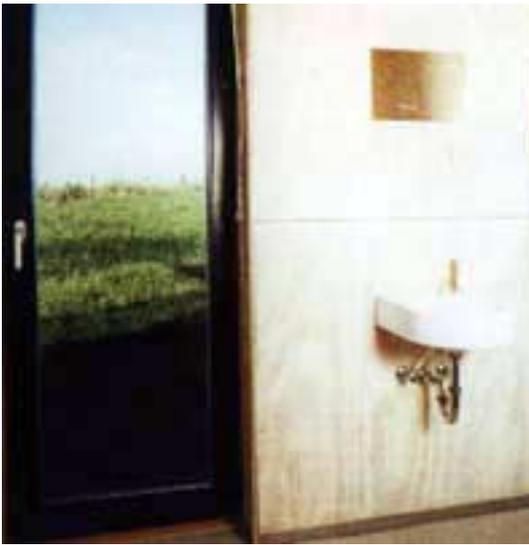
Abbildung 143 Wandbekleidung im Bad aus lasiertem Sperrholz<sup>722</sup>
