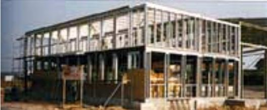
Abbildung 111 Rohbau-Konstruktion in Stahlleichtbauweise<sup>587</sup>
