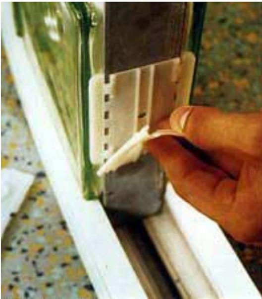
Abbildung 129 Alurahmenprofil, Flacheisen und Combi-Clip
