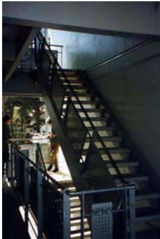
Abbildung 94 Holzterre mit Betonstufen<sup>524</sup>
