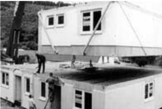
Abbildung 115 Montage der Raummodule<sup>594</sup>
