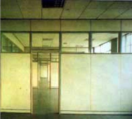
Die Standardabmessungen der Platten sind 62<sup>5</sup> cm x 2,60 m oder 3,00 m.<sup>305</sup> Somit ergibt sich ein sinnvolles Achsmaß für die Ständer von 62<sup>5</sup> cm, oder ein Grundraster von 1,25 m bei vertikaler Beplankung. Der handwerkliche Aufwand auf der Baustelle ist dabei immer noch recht hoch.
