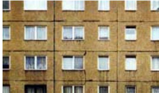
Abbildung 20 Fugenproblematik beim Plattenbau<sup>64</sup>
