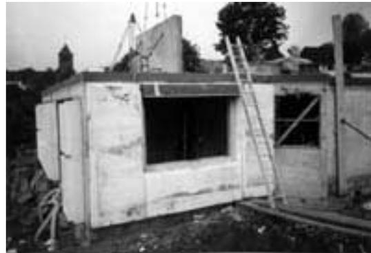
Abbildung 48 Wandelemente vor der Montage, beim Einbau<sup>267</sup>
