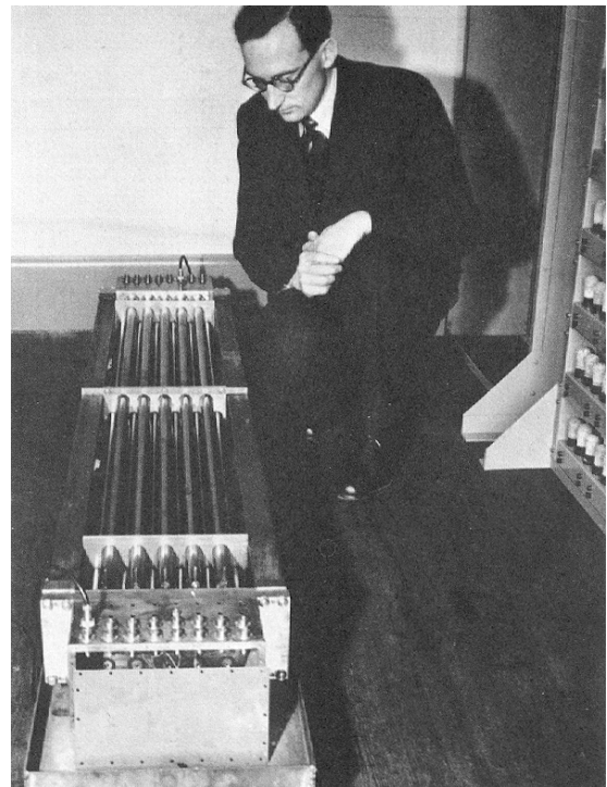
Delay Lines des EDSAC
