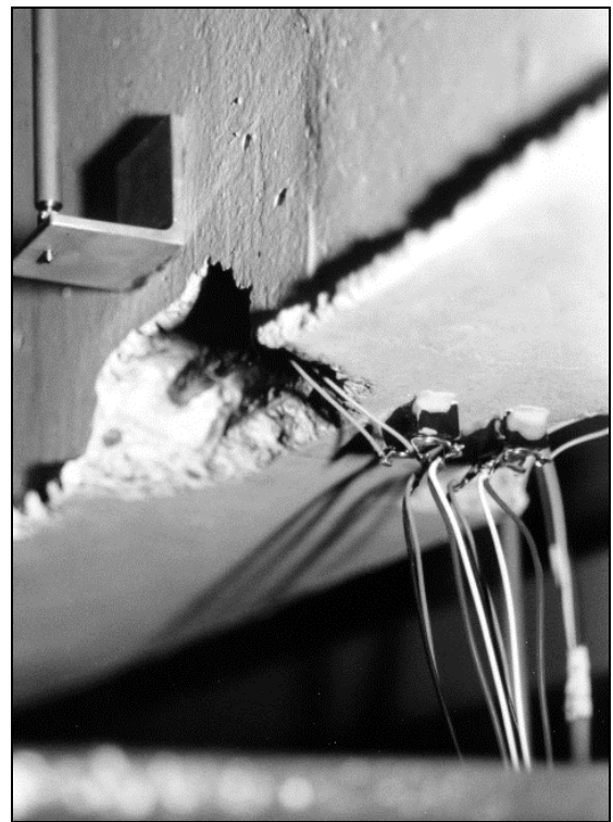
Abb. 35: Dehnungsmeßstellen an der Längsbewehrung
