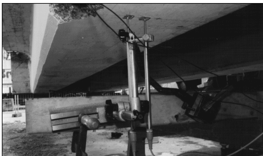
Abb. 55: induktive Wegaufnehmer zur Messung der Durchbiegung in Balkenmitte
