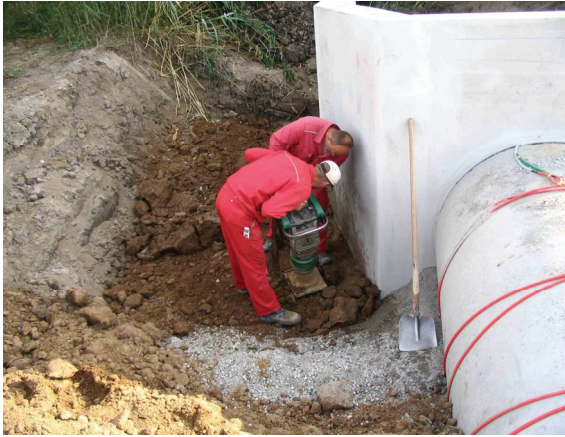
Bild 9: Auslaufbauwerk wird in den Erd- baustoff des Deiches eingebunden [HPI]
