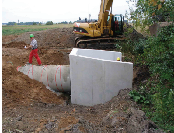
Bild 10: Verpressschläuche am Sielrohr zur flächigen Bodenvergelung [HPI]
