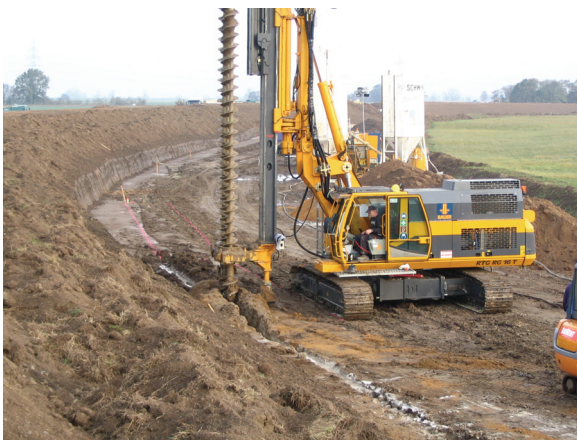
Bild 7: Herstellen einer Untergrundabdichtung im Zuge der Baumaßnahme durch Bodenvermörtelung - Mixed-in-Place-Verfahren
