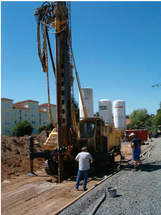
Bild 5: Gerätetechnik bestehend aus Bohrgerät, Gestänge und HDI-Düse beim Verpressen des Injektionsstoffes [ipr-consult]
