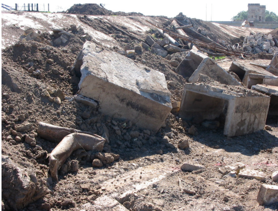
Bild 5: Ausbau von Fundamenten einer alten Fernwärmetrasse während der Bauphase [HPI]
