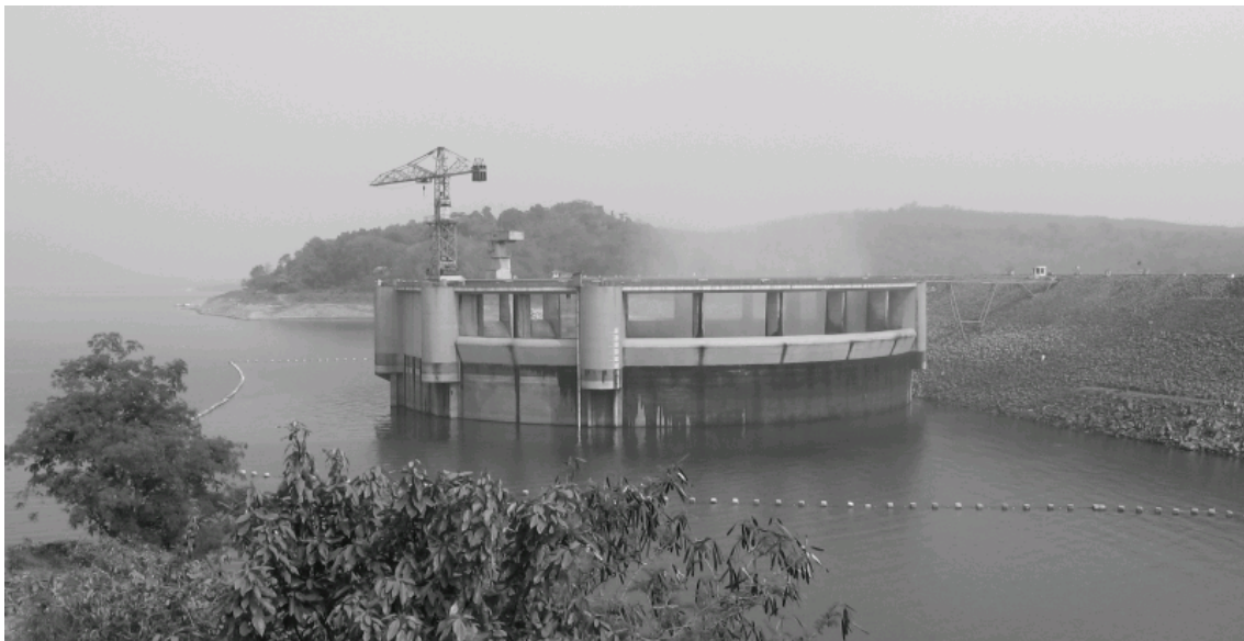
Abbildung 2: Jatiluhur Steinschüttdamm mit Schachtüberfall
