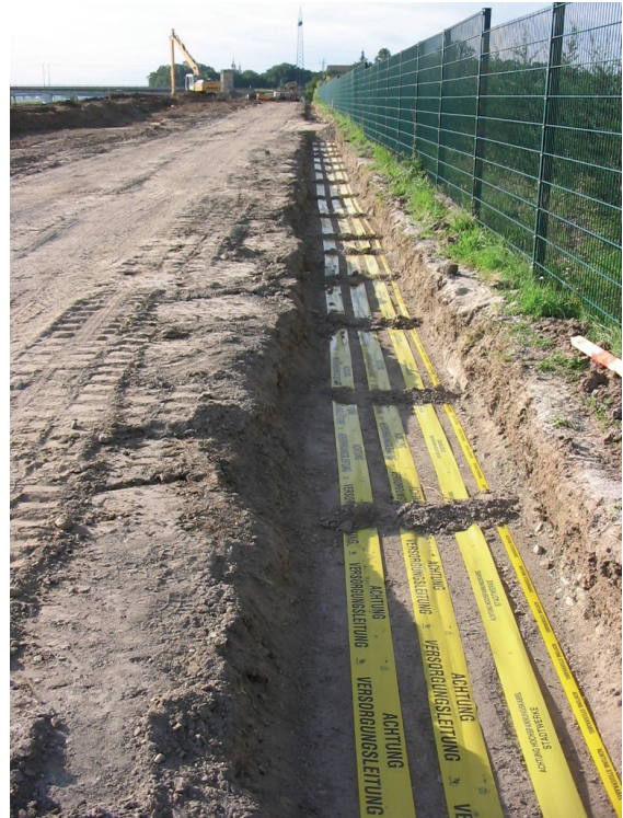
Bild 4: Ordnungsgemäße Kabelverlegung außerhalb des Deichschutzstreifens nach Umverlegung [HPI]
