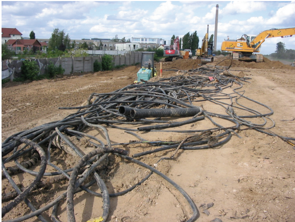
Bild 3: Zahlreiche Leitungen waren planmäßig zurückzubauen, darüber hinaus wurden Kabelanlagen gefunden, die nicht mehr in Betrieb waren [HPI]
