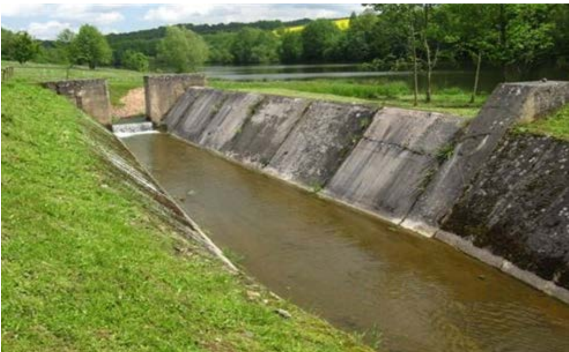
Überlaufschwelle mit Sammelrinne der HWE
