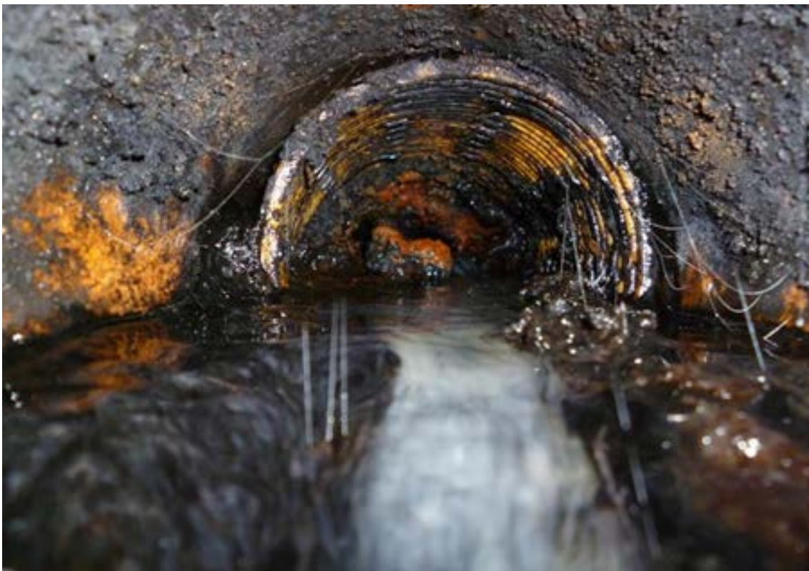
Sedimentversatz Dammfußdrainage
