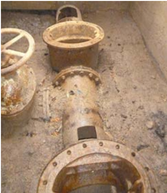
Demontierte Schieber, korrodierte Grundablassleitung
