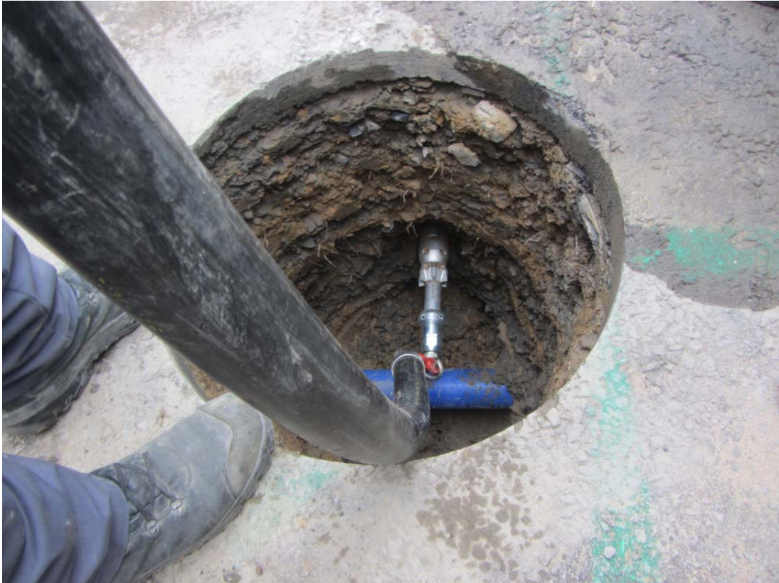
Abbildung 3: Absaugen des Bodenmaterials aus dem Bohrloch
