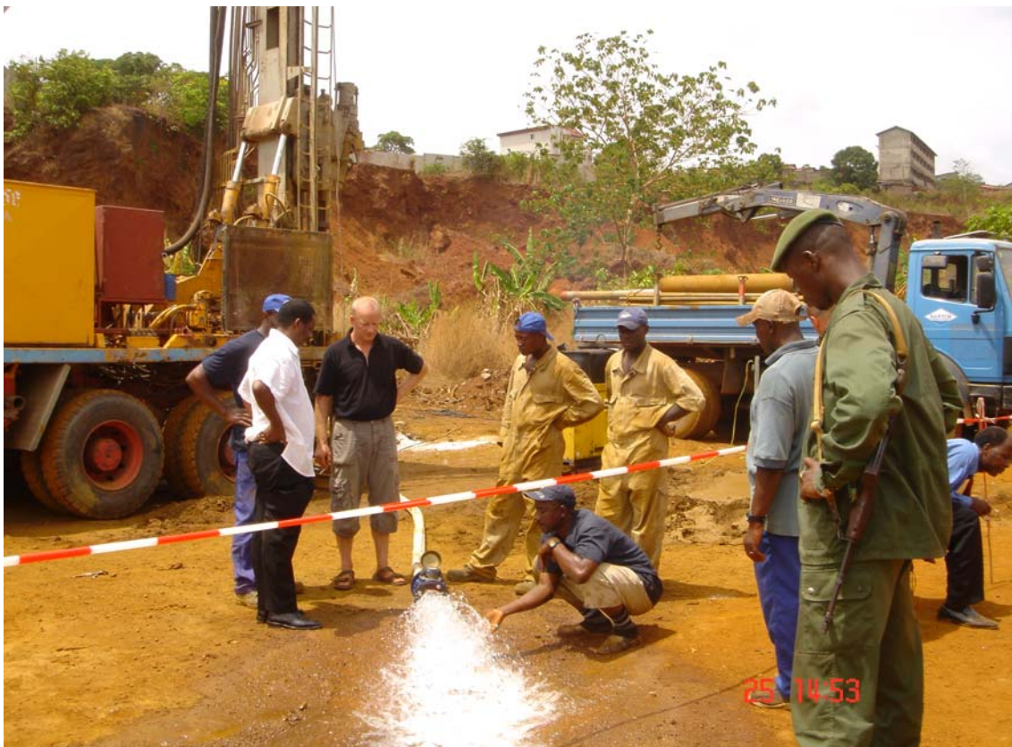
Abb. 3: Bohrarbeiten in Guinea
