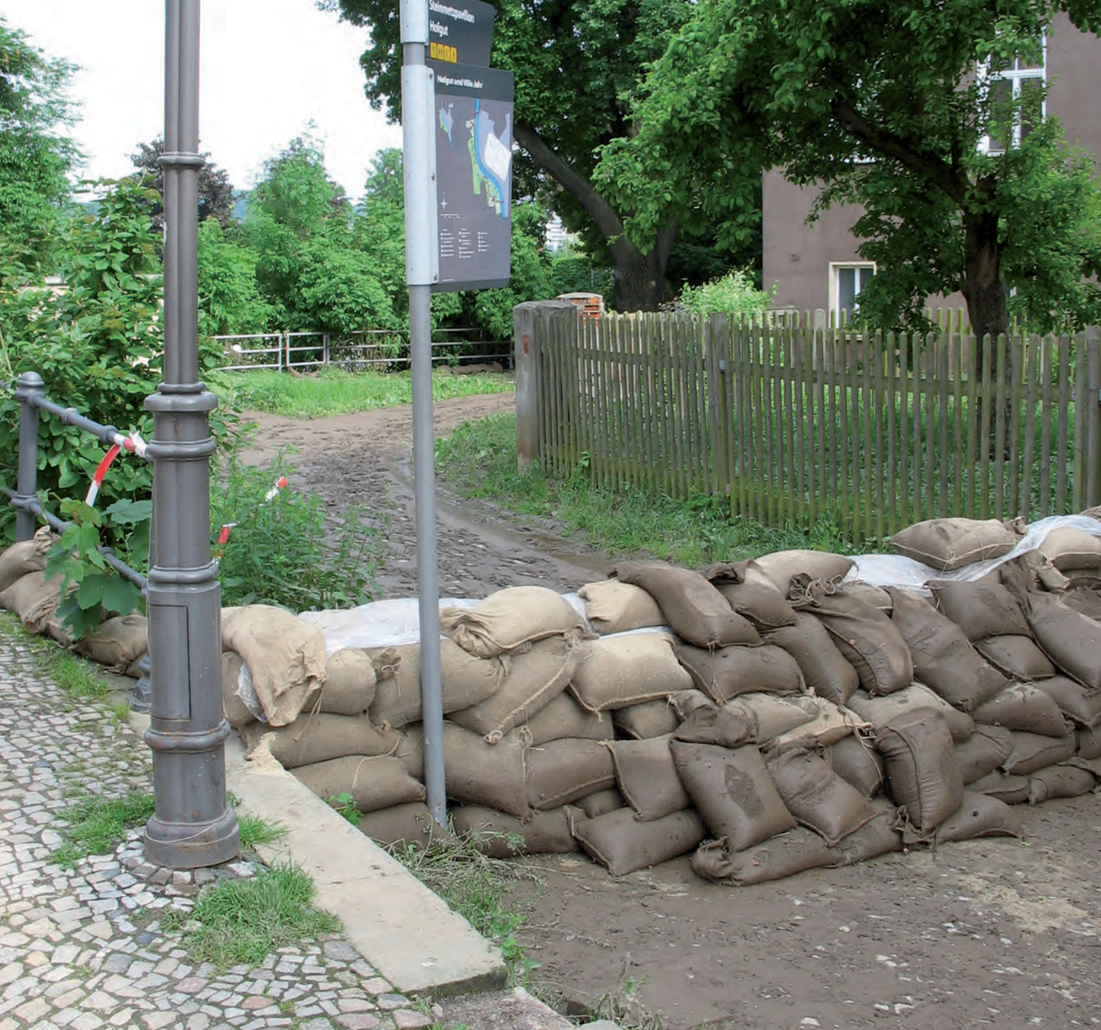
Sandsackverbau nach abgelaufenem Hochwasser, Foto: TLUG
