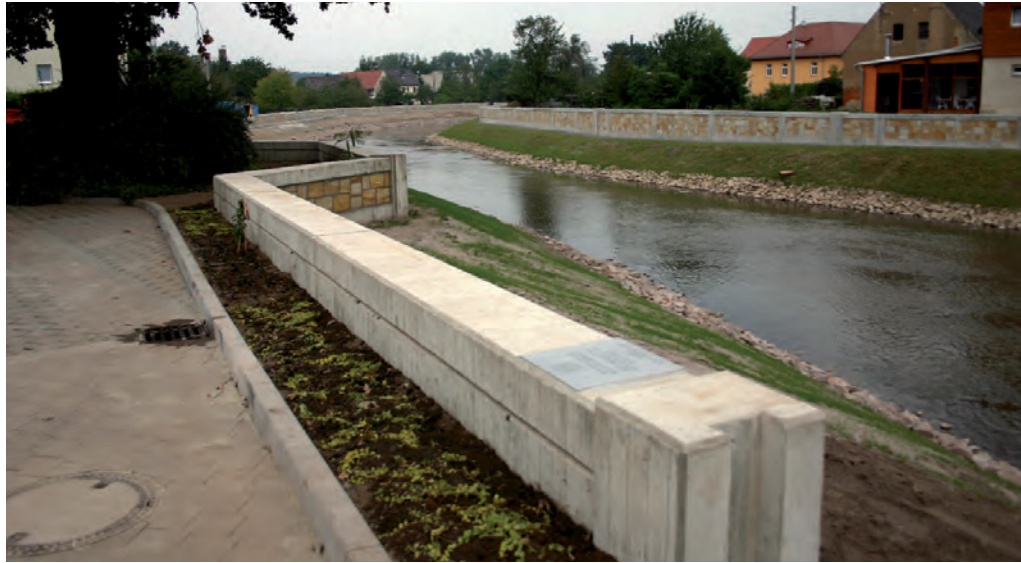
Hochwasserschutz-Mauer in Treben, Foto: TMUEN
