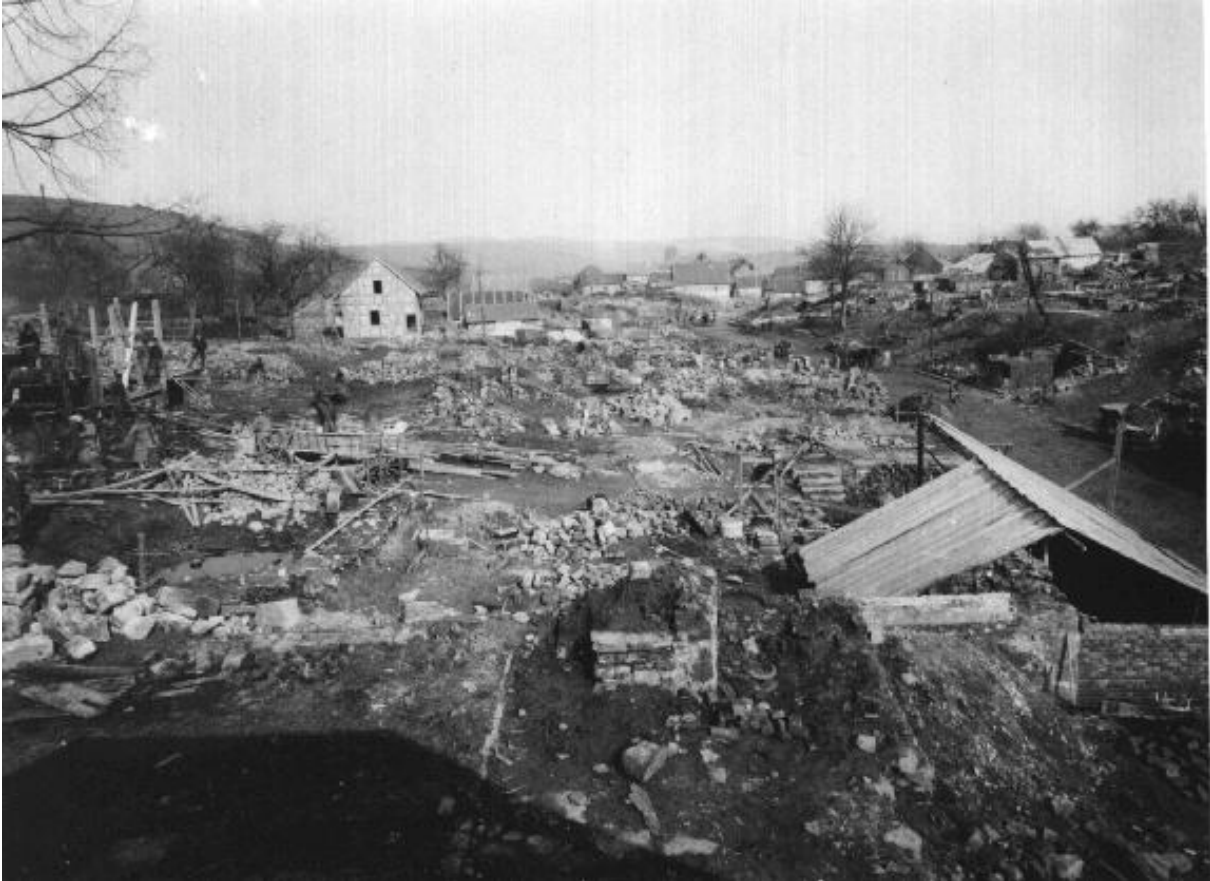
Wiederaufbau nach dem Brand - Foto aus Richtung der alten Schule
