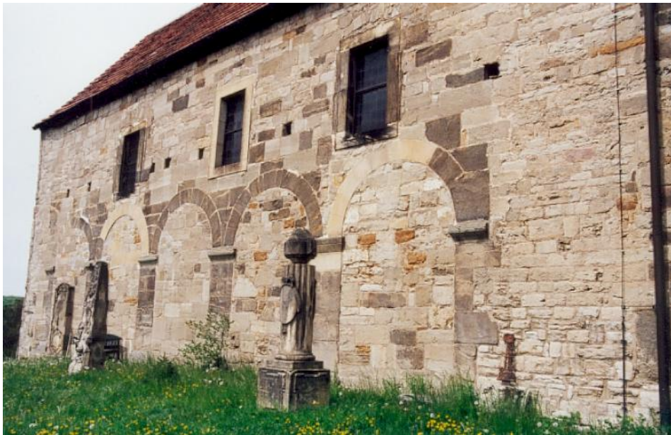
Diese Säulen und Bögen zierten einst das Innere der Kirche.
