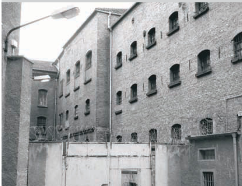
Innenhof, Blick auf den Stasi-Zellentrakt und Freigangsbereich
