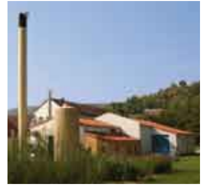
↑ Modernes Strohheizkraftwerk in Jena.
